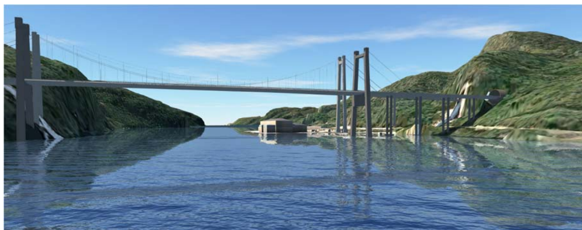
Figur 2-9. Utsnitt av modell, sett ut over Fedafjorden. Dagens tofelts bru er ytterst, modellert ny firefelts bro innerst.
