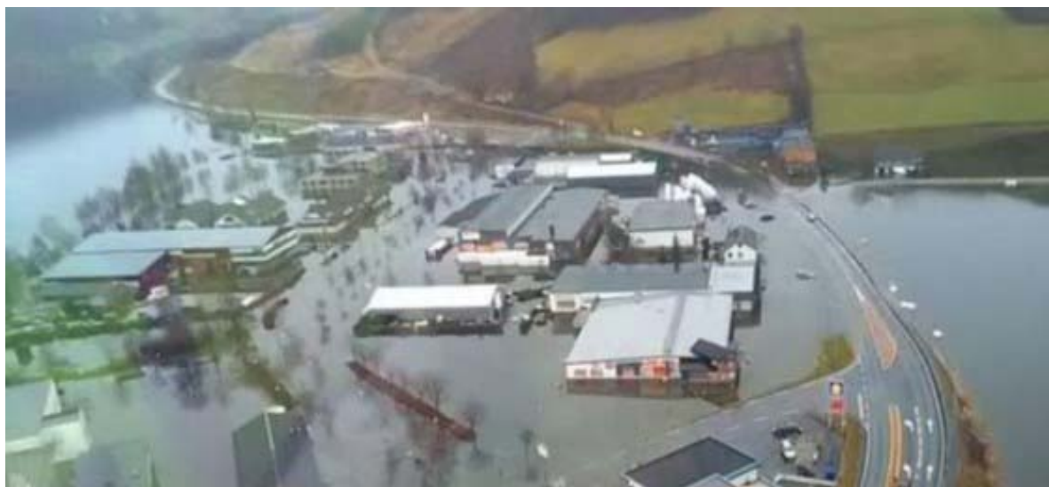
Figur 55. Det er flere vassdrag og store nedbørsfelt i planområdet. Deler av dagens strekning er flomutsatt og det har vært flere episoder der dagens E39 har stått under vann i lengre perioder. Det er utført flomanalysene for 200-års flomvannføring med påslag for klimaendringer. Ny E39 er lagt slik at vegen ikke skal være flomutsatt. Bildet er fra Vikeså i 2015 hvor dagens E39 og store deler av sentrum sto under vann.
