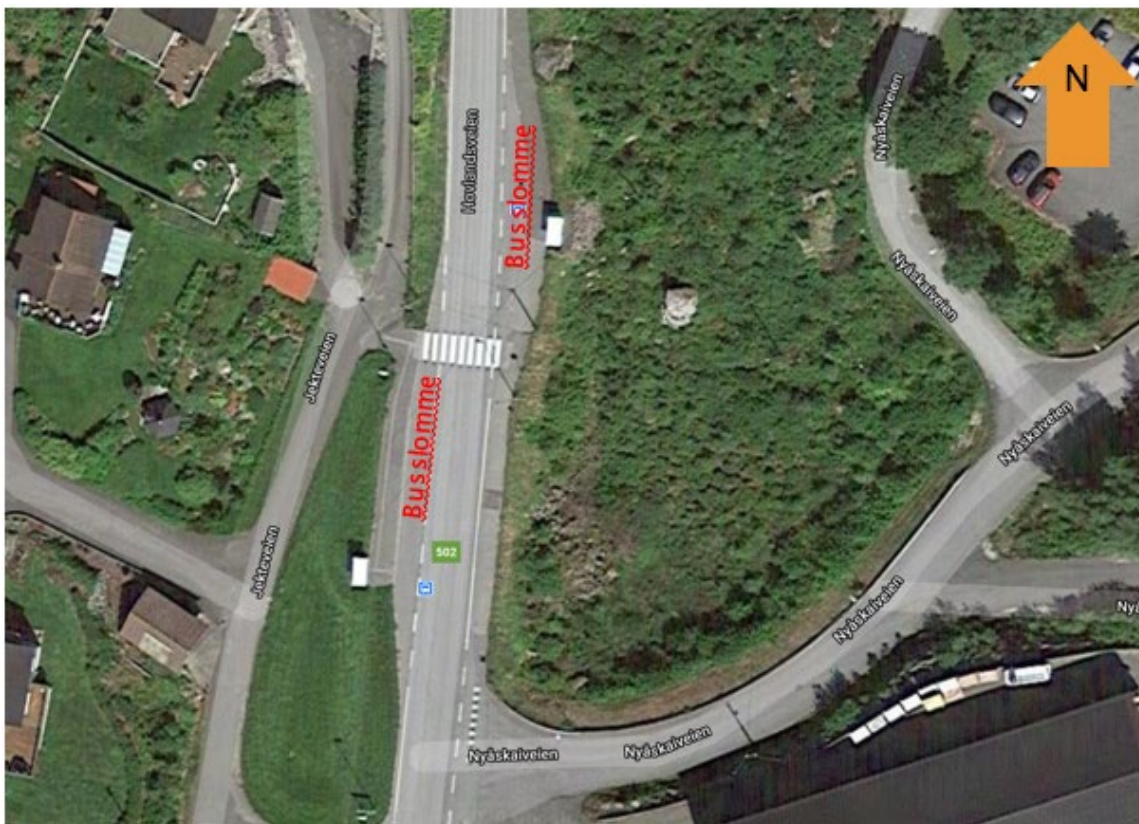
Figur 3.2: Busstopp langs Hovlandsveien
