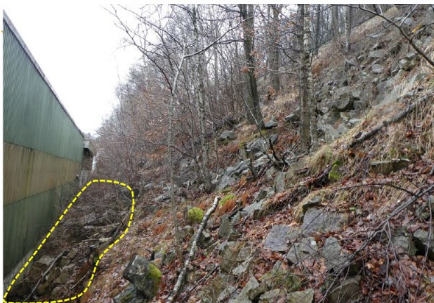
Figur 3.5. Løsmasseskråning, tett inntil industribygg. Avgravn skråningsfot i synlig del av skråning er skissert med gult omriss. Området hvor ny gang- og sykkelveg skal etableres kan ses i øvre høyre del av bildet.
