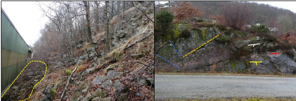
Figur 36: Bilde til venstre viser løsmasseskråningen ved del av industribygg. Avgravd skråningsfot i synlig del av skårning markert med gult. Bilde til høyre viser ulike sprekkesystem. Figur hentet fra rapport levert av Norconsult.
