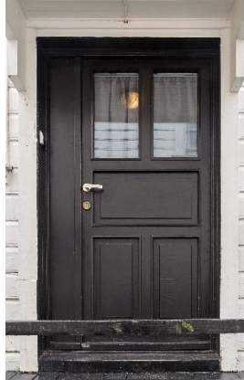
Standard dør med tett sidefelt er satt inn i stedet for tofløyet symmetrisk ytterdør.
