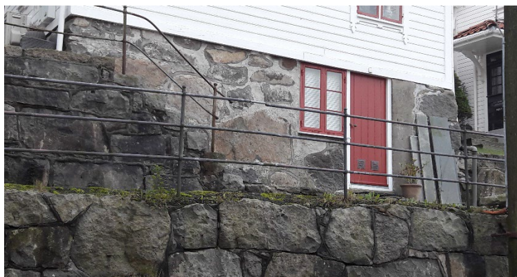
Gammel ubehandlet grunnmur – bør beholde sitt utseende. Kombinasjon av naturstein og betong.
