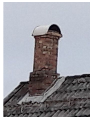
Tradisjonell pipe i tegl
