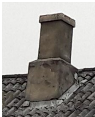
Tradisjonell pipe (pusset tegl)
