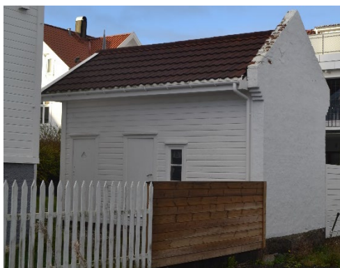
Gamle uthus i Sandakergaten
