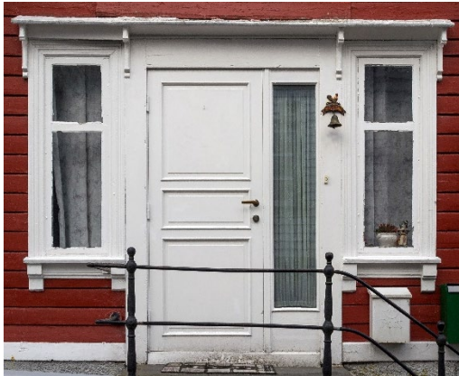
Standard dør med sidefelt i glass er satt inn i stedet for symmetrisk tofløyet dør i sveitserstil.
