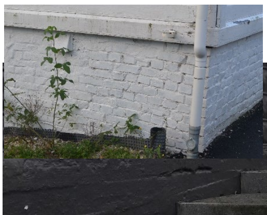
Gammel ubehandlet grunnmur – bør beholde sitt utseende. Kombinasjon av naturstein og betong.
