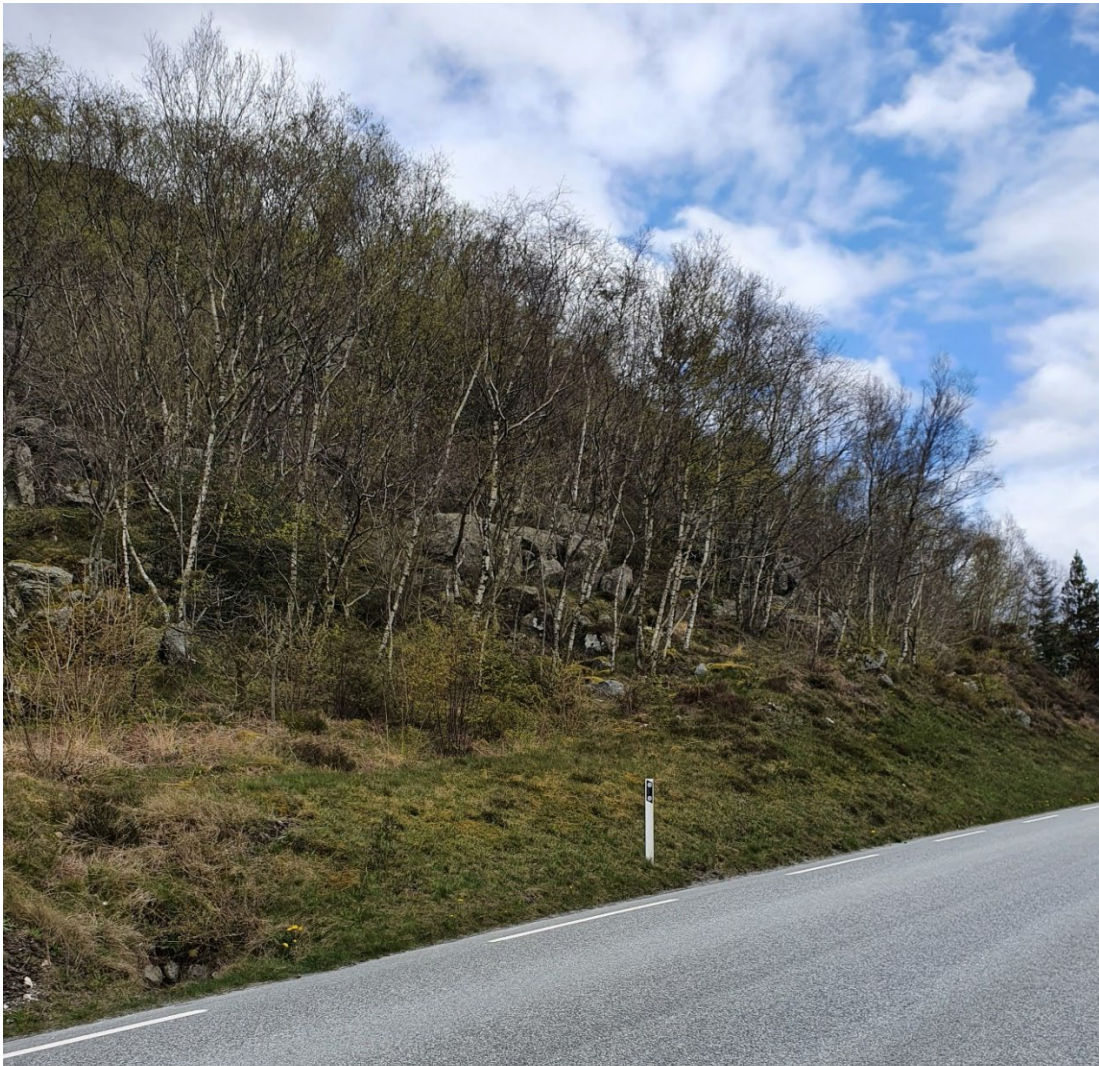
Figur 6-1. Løsmasseskråning med helning opp mot 1:1,1 som innehar et større parti av blokker i topp.
