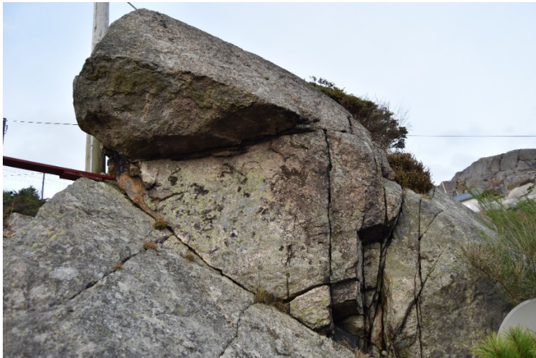
Figur 25: Blokk som bør sikrast med eit par boltar før sprenging.
