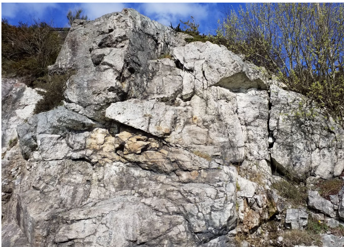
Figur 24: Detaljbilde fra eksisterende skjering, om lag profil 910.
