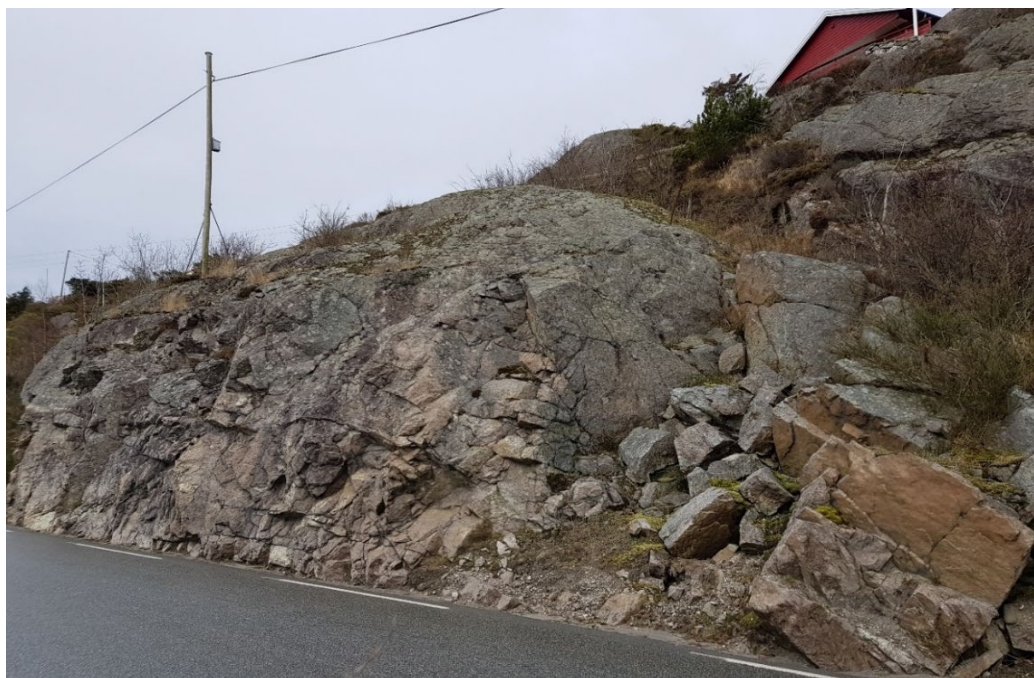
Figur 28: Eksisterande skjering ved om lag profil 990.
