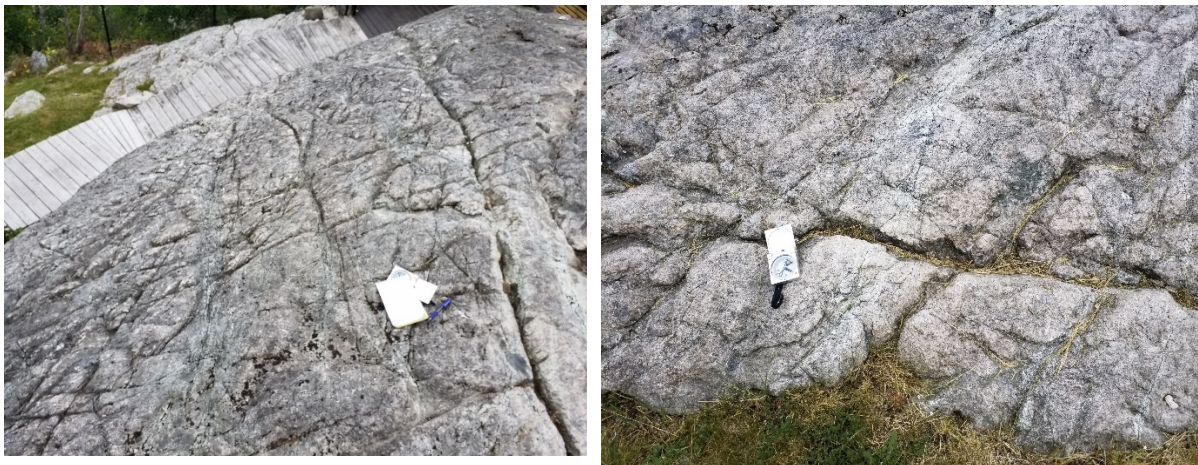
Figur 22: Moderat til tett oppsprukken bergmasse med opne sprekkar
