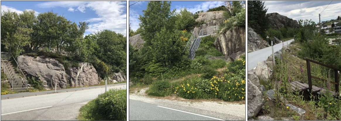
Figur 13: Private trappeadkomster direkte ut i fylkesvegen.
