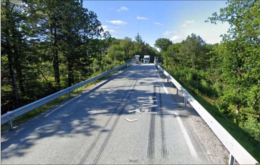
Figur 7: Brua som går over jernbanen. Vegen er smal og sikten dårlig, og frihøyden under brua er for lav.
