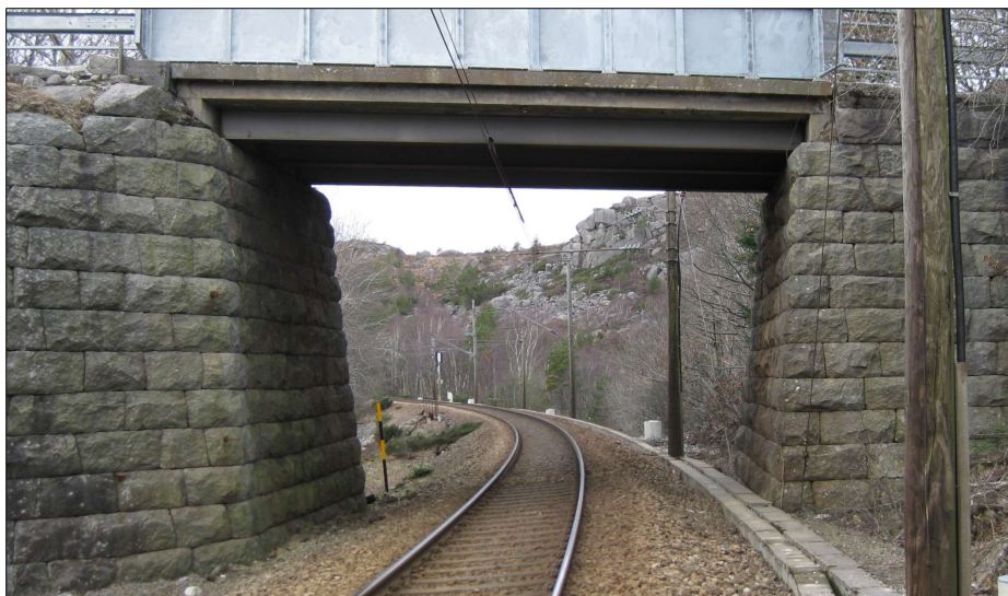
Figur 11: Brua Hellvik II krysser Jærbanen.
