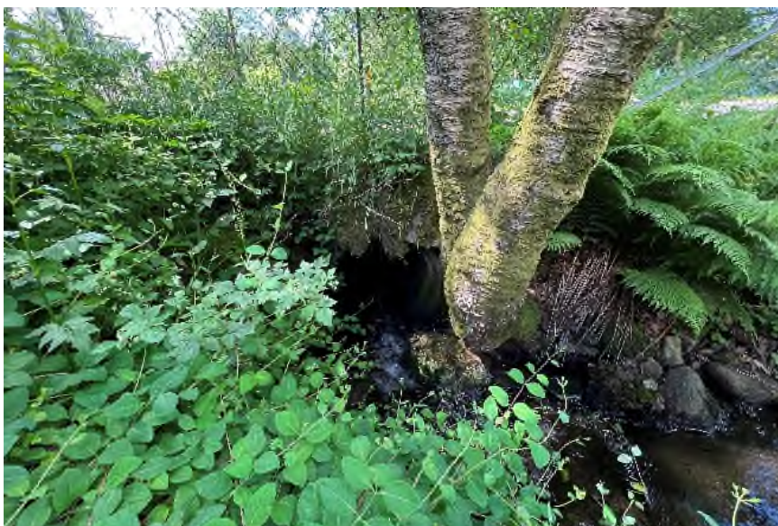
Figur 9. Stasjon 3: stasjonen ligger oppstrøms liten kulvert under gårdsvei.
