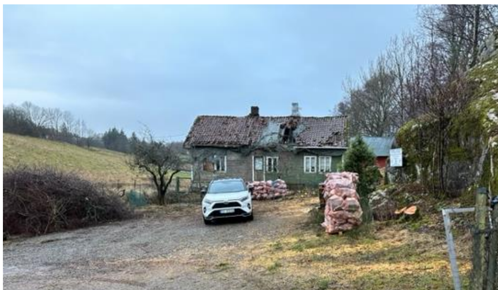
Figur 11: Eksisterende våningshus på gårdstunet.
