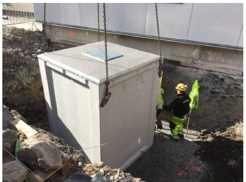
Eksempel på lossing / plassering av kum med kulehoder/løfteankere.
