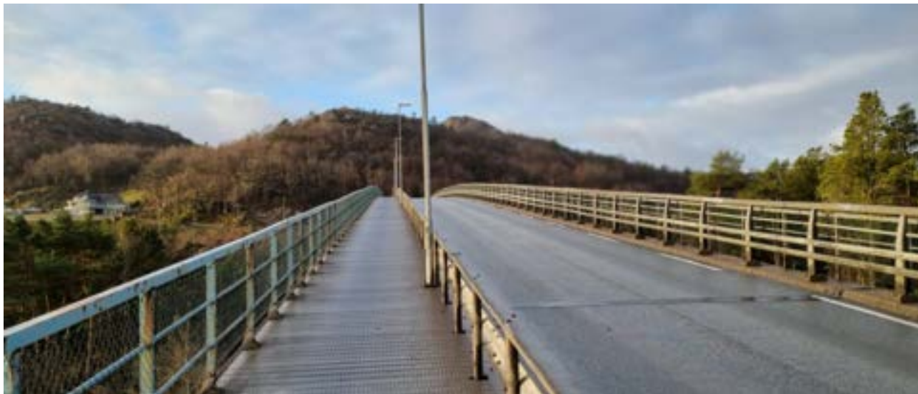
Figur 4-9 - Dagens bru til Eigerøy (bilde: Multiconsult)
