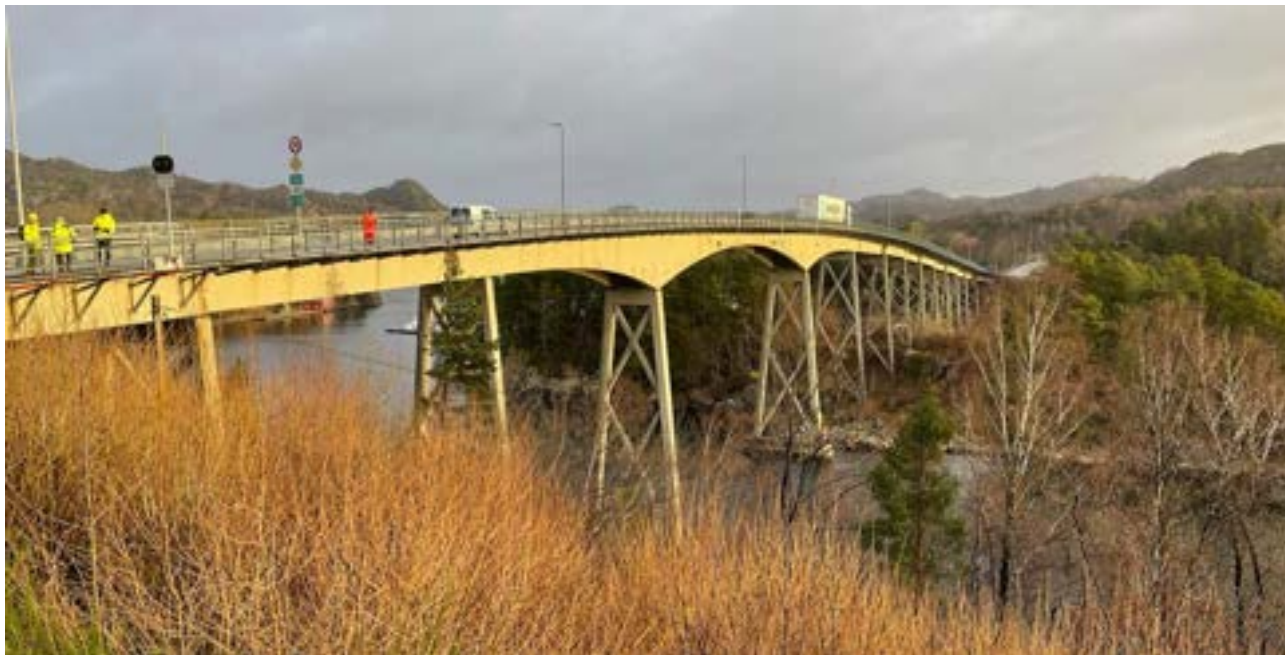
Figur 4-2 - Dagens bru til Eigerøy (bilde: Multiconsult)
