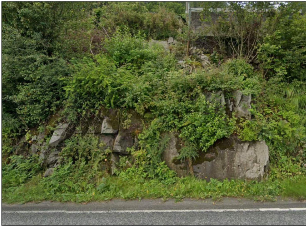
Figur 3.2: Bergskjæring i nærheten av planlagt skjæring 1. Bildet er hentet fra Google Maps street view (7)
