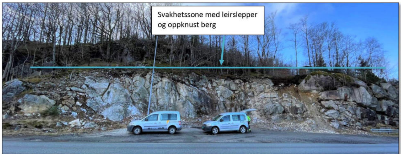
Foto 3.1: Oversiktsbilde av eksisterende skjæring i midtre del av hvor skjæring 2 skal etableres. Blå strek viser området hvor det er observert en svakhetszone.
