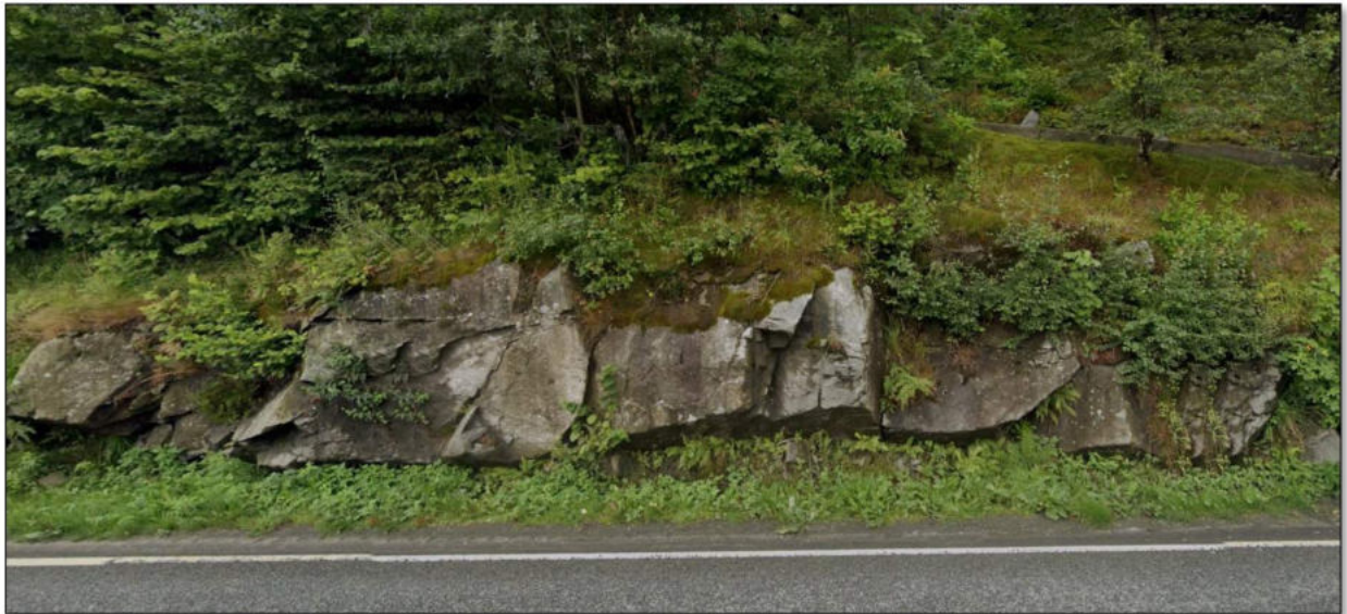
Foto 3.3: Mindre bergskjæring i sørlige del av planlagt skjæring 2
