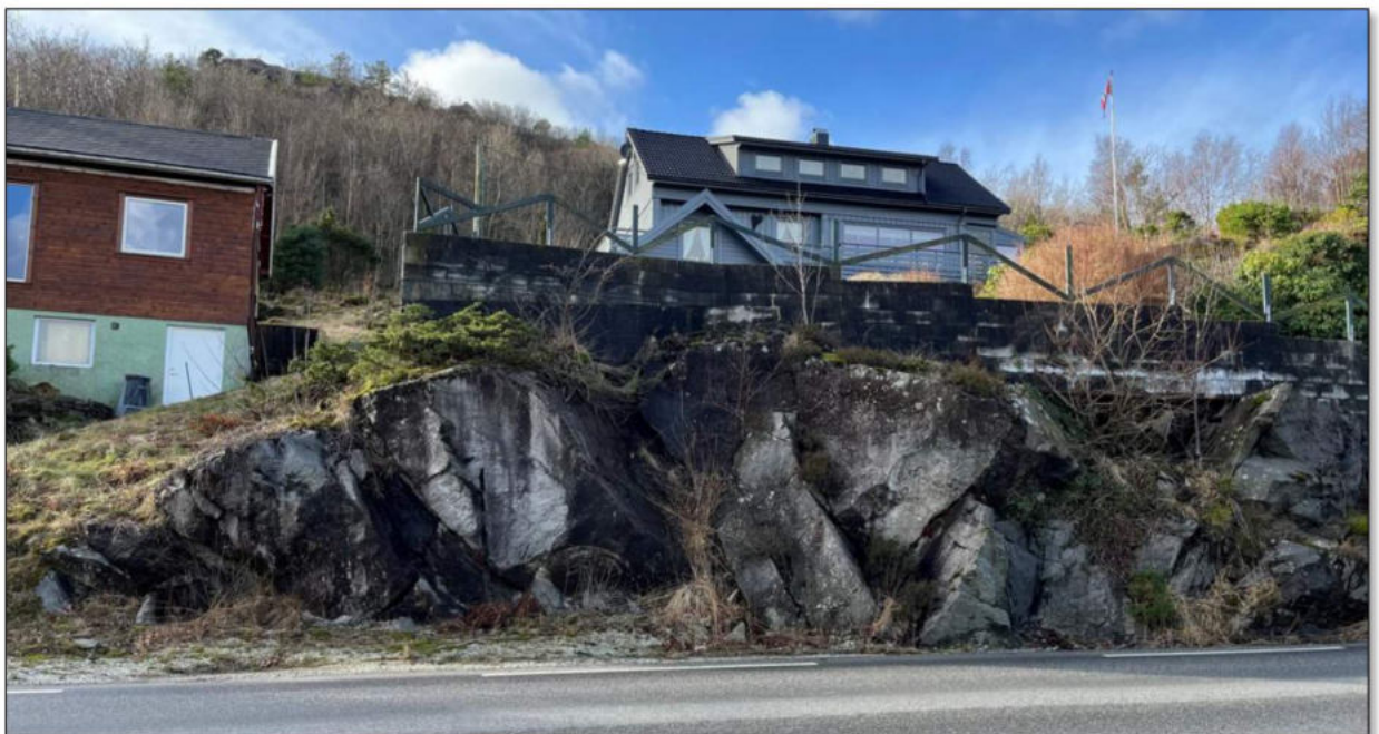
Foto 3.4: Bergskjæring i nordlige del av planlagt skjæring 2.
