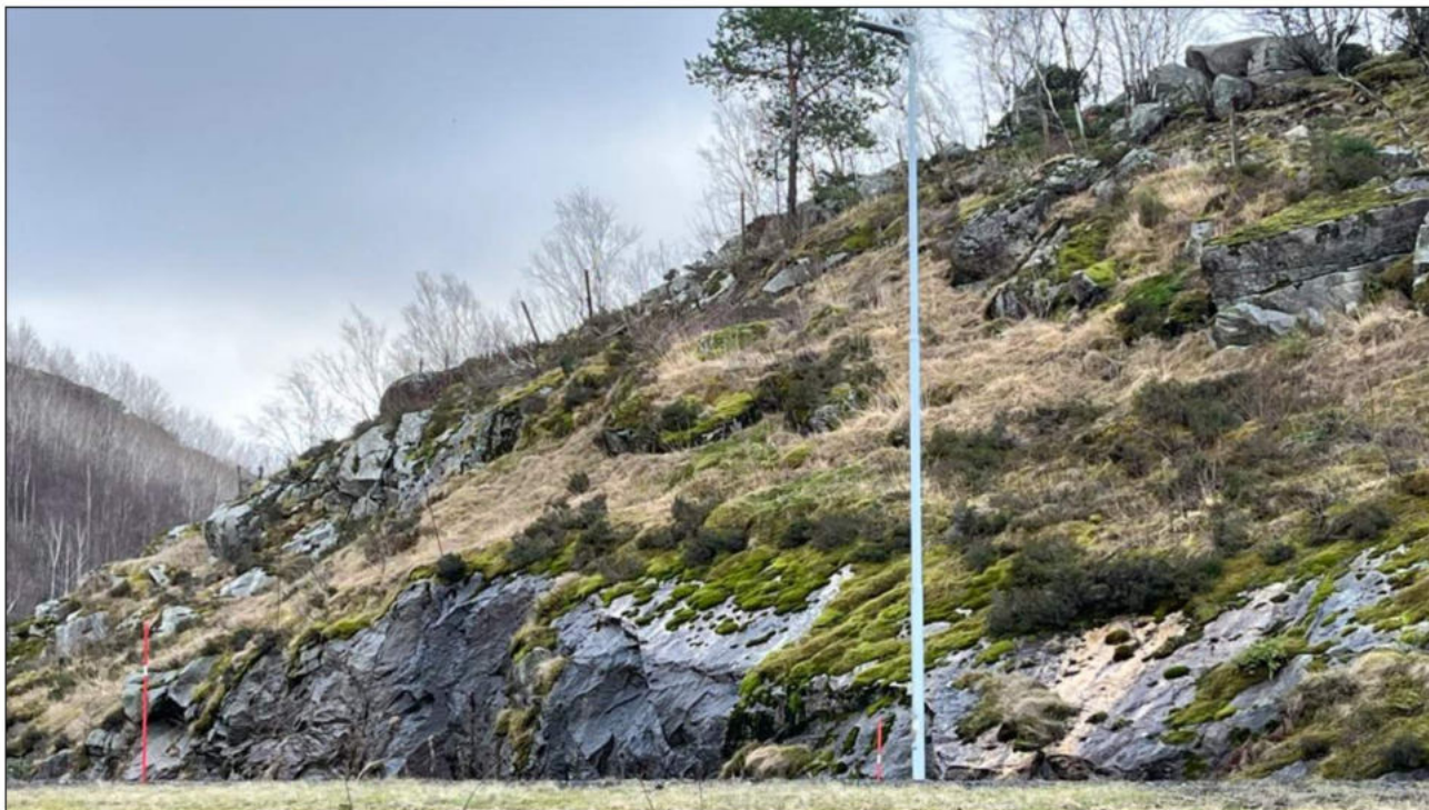
Foto 4.1: Oversiktsbilde av bergskråning 2
