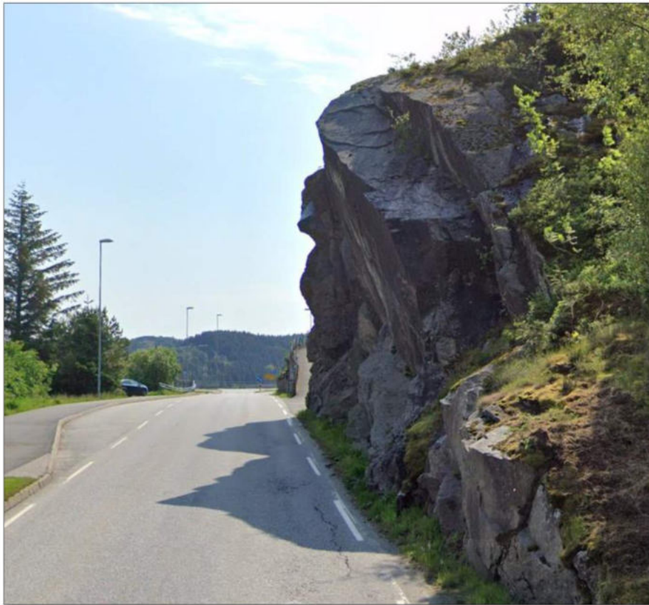
Foto 3.6: Eksisterende skjæring i nærheten av hvor skjæring 3 er planlagt å etableres, sett fra nord mot sør
