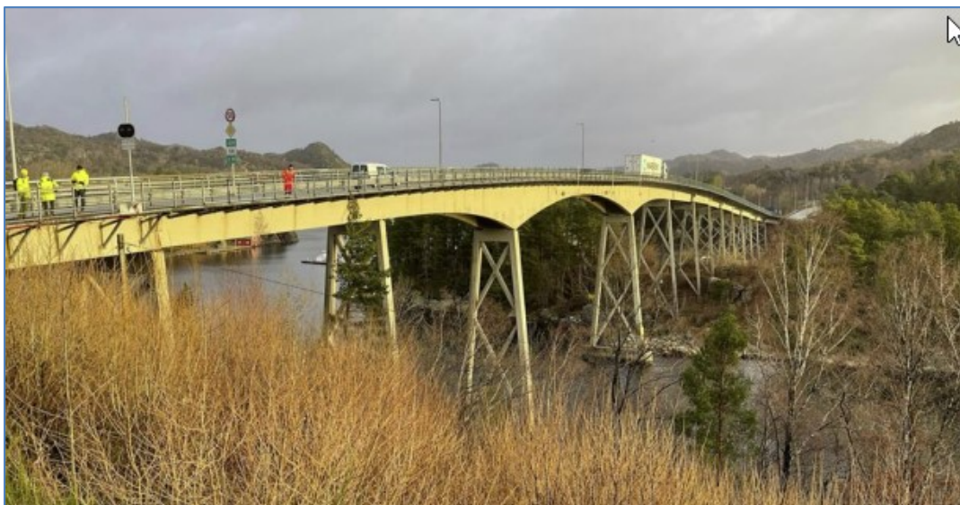
Figur 3 Bilde av dagens bru
