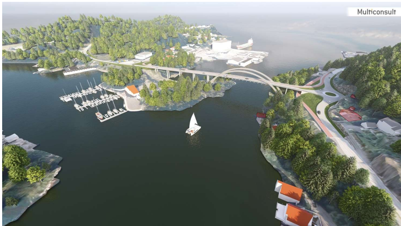
Figur 1 Alternativ 1, buebru i betong med mellomliggende stålkassebue.
