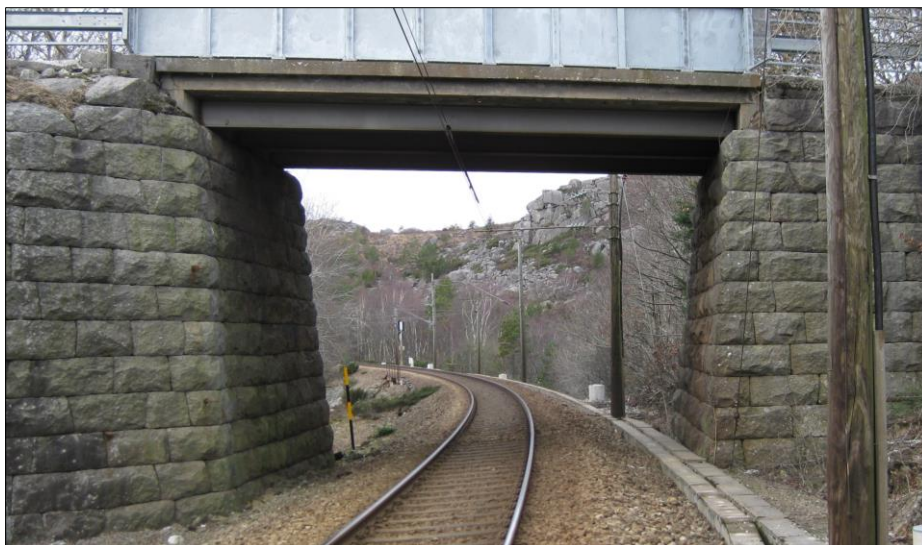
Figur 11: Brua Hellvik II krysser Jærbanen.
