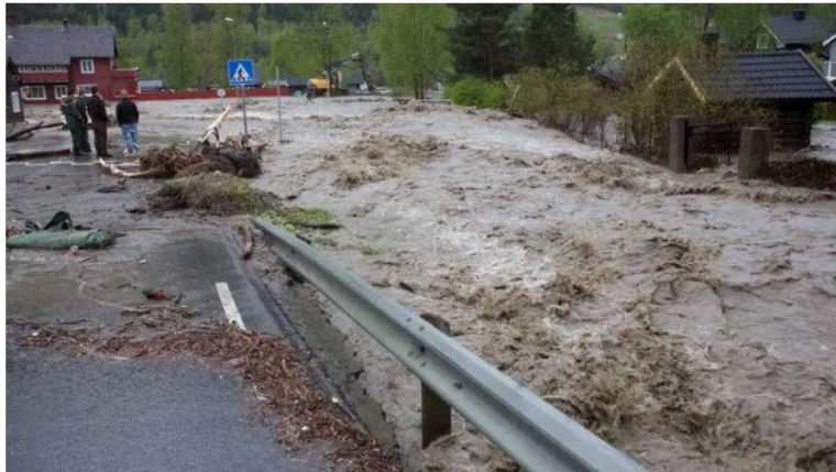
Elva har funnet en ny trasé ved siden av en av hovedveiene i Kvam. Foto: Dag W. Grundseth
