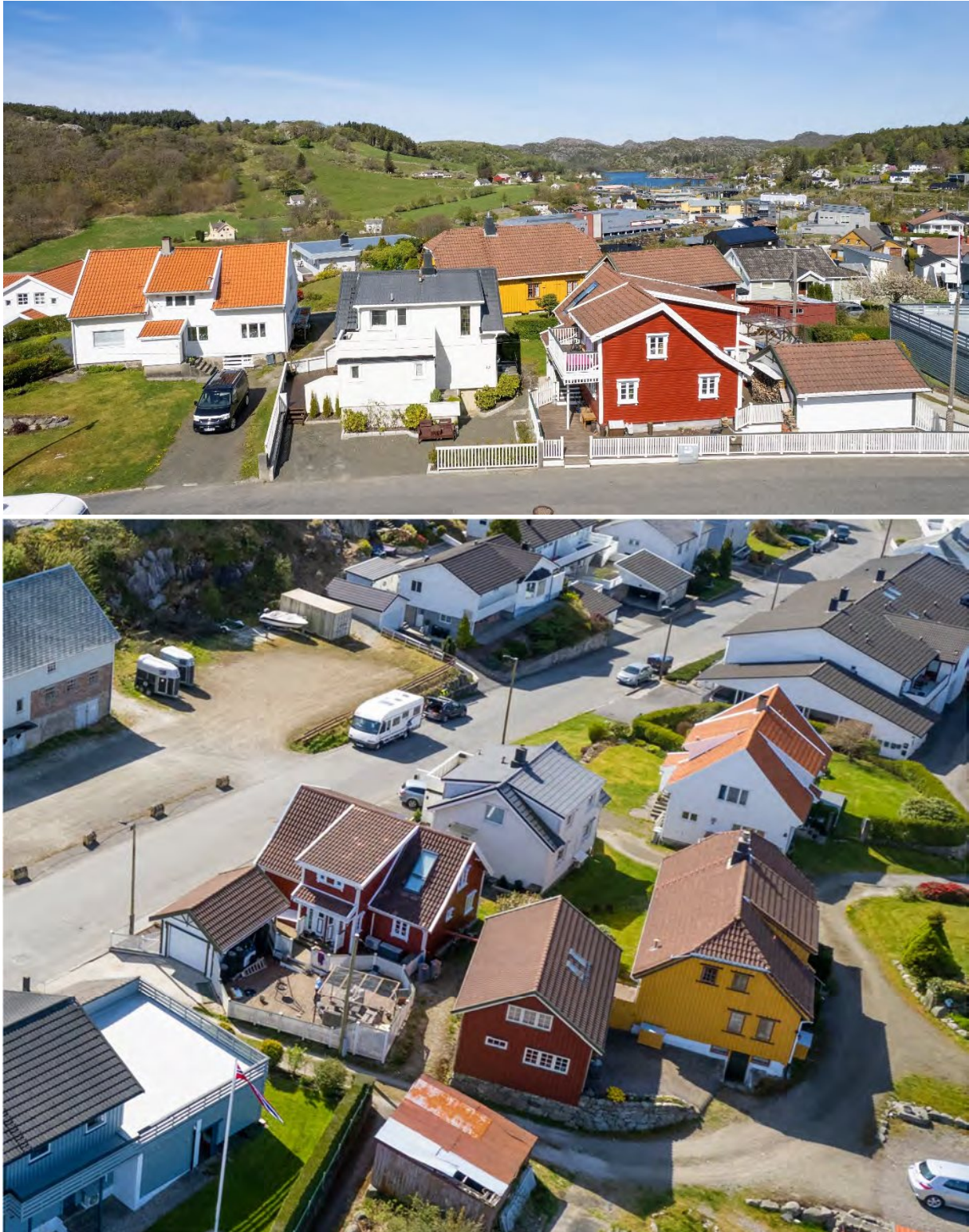
Figur 18: Bevaringsverdig bygningsmiljø "Hafsøy gård". Flere av bygningene er ombygget i nyere tid med mer moderne utforming som bl.a takvinduer. Foto: Megabite.no
