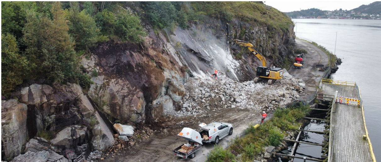
Veiprosjektet i Varbergveien like etter oppstart (august 2023).
