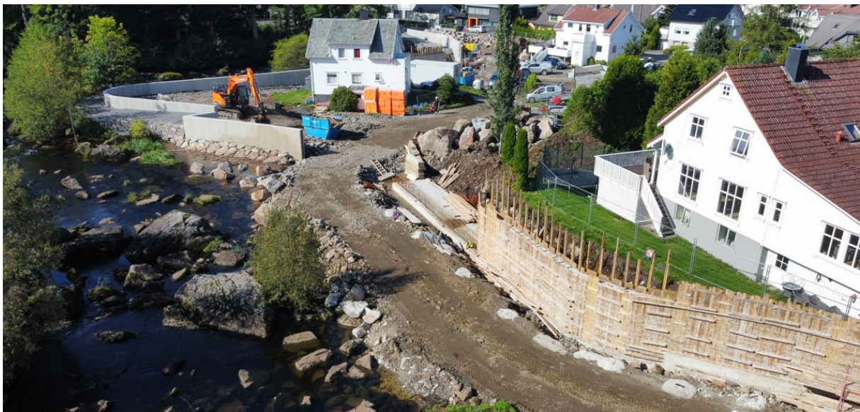
Arbeid med flomsikring i øvre del av Lundeåna (august 2023)
