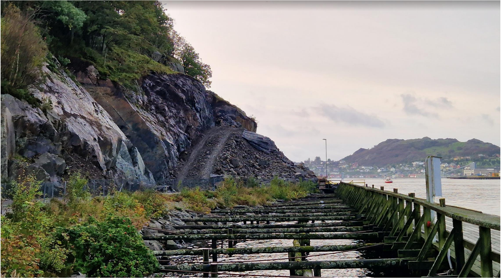
Varbergveien ved "Tyskerbrygga"
