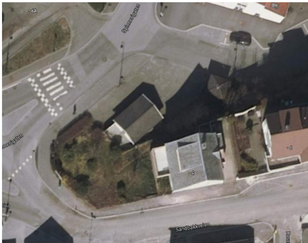
Fig. 5: Førstusjon med bolig som skal rives
