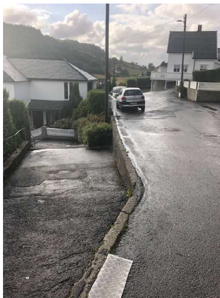
Figur 6-1 Humlestadgaten og trapp mot Jernbaneveien
