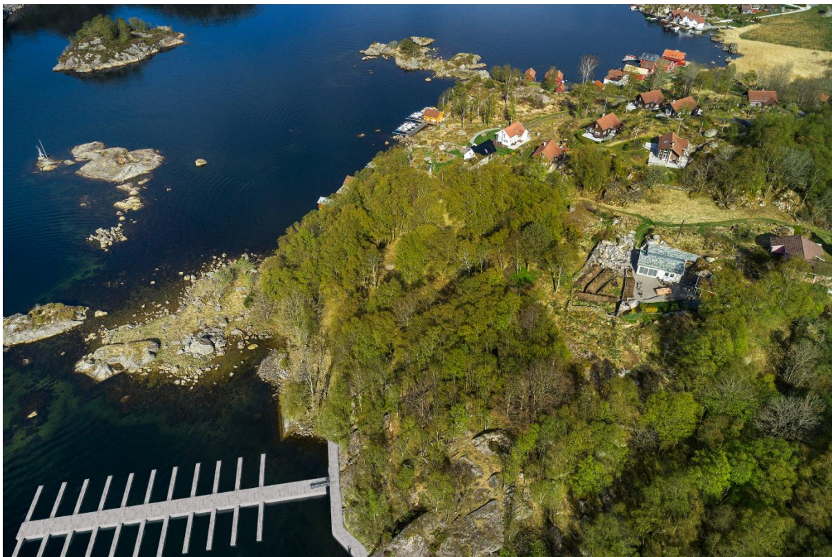
Figur 28: Småbåtanlegg med landfast brygge sett fra vest.
