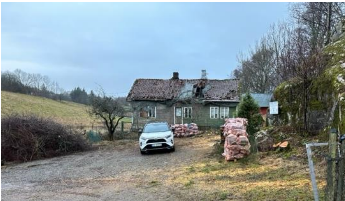
Figur 11: Eksisterende våningshus på gårdstunet.
