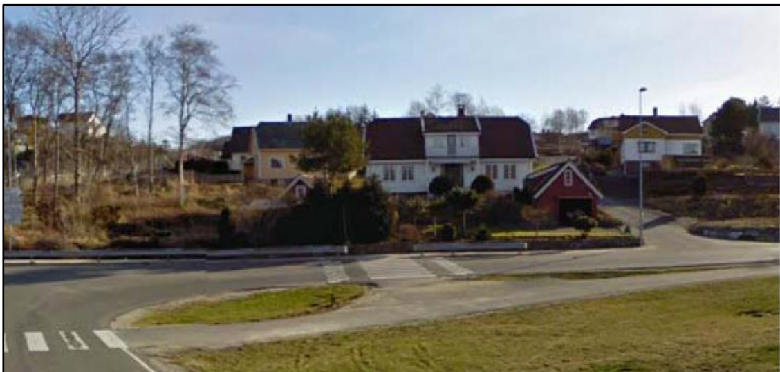
Figur 5. Opphøyd gangfelt over Kvidafjellveien. En forbedring av gatebelysning anbefales, slik at gangfeltet belyses bedre.
