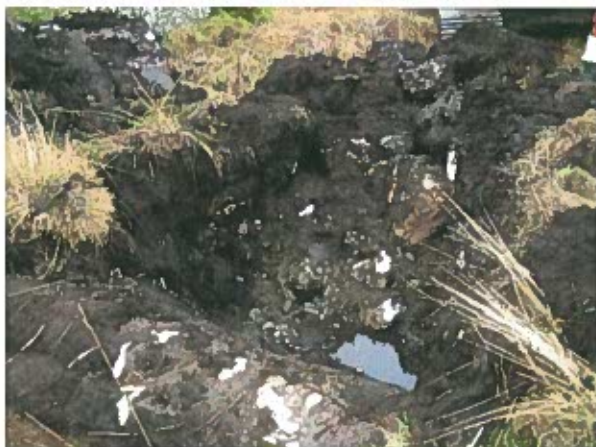
Figur 6: Prøvesjakt 5 underveis i graving.
