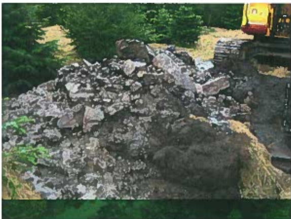
Figur 3: Prøvesjakt 2, oppgravd masse underveis.
