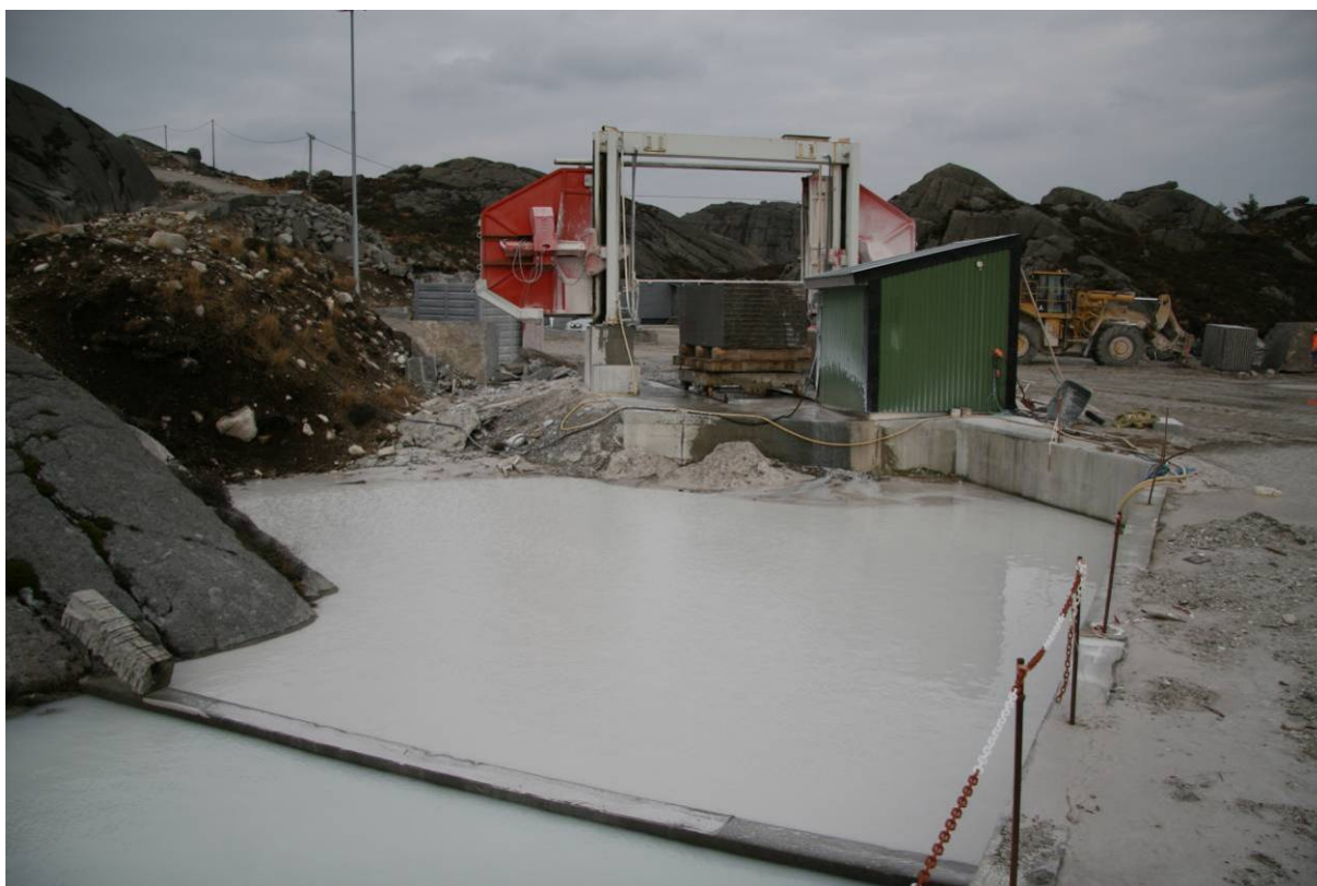
Figur 2.7. Dagens sedimentasjonsdammer ved sagen
