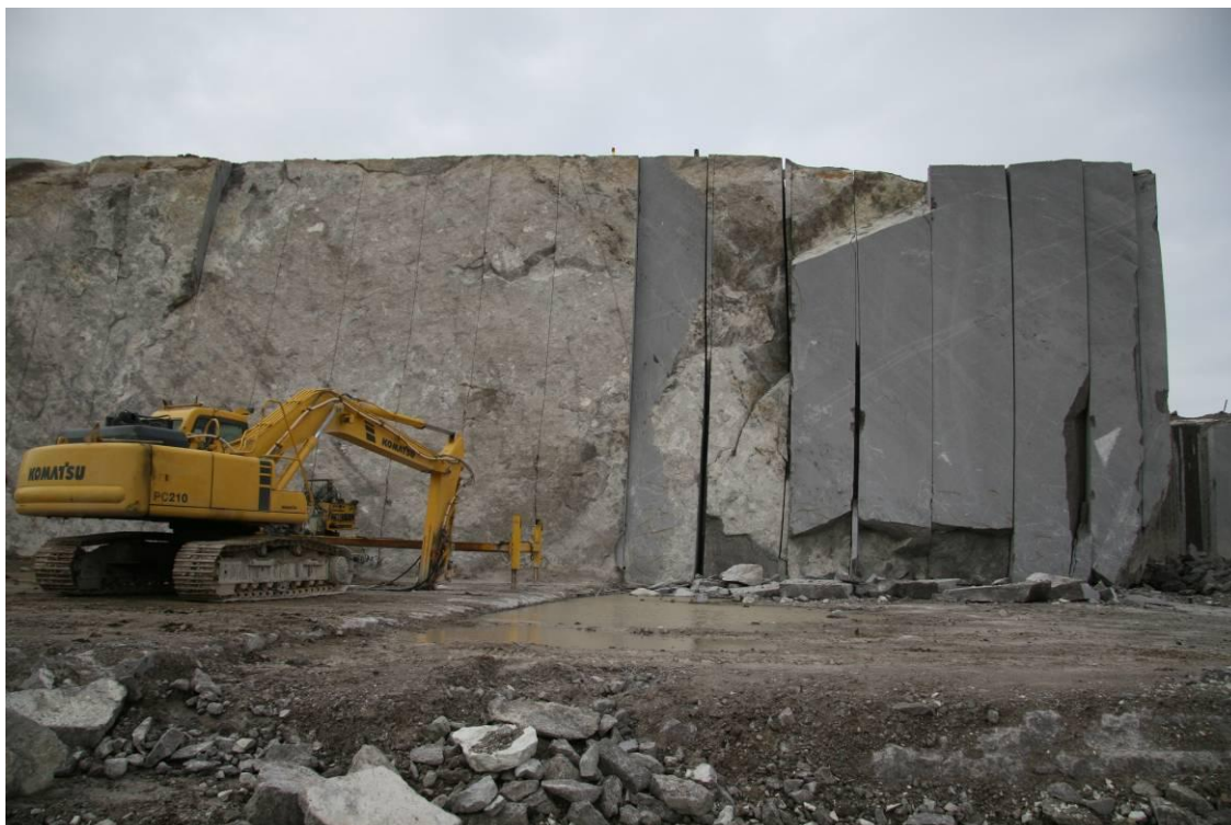
Figur 2.2. Palledrift vest i uttaksområdet, pallene sages ved hjelp av diamant-wire sager og sprenges løs
