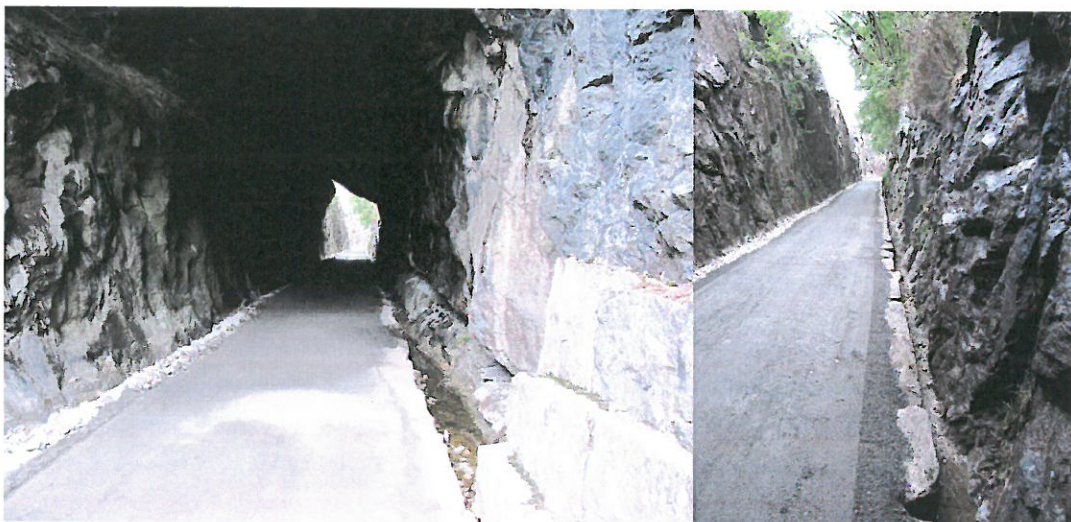
Grøfterensk, istandsetting av grøftestein og nytt veidekke i tunnel og skjæring.
