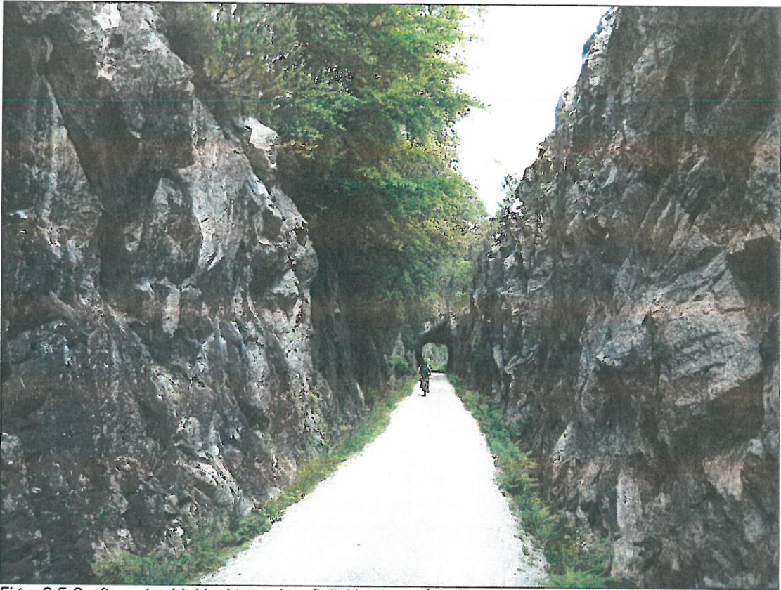
Figur 3.5 Grøfter og veidekke i tunnel og fjellskjæring må utbedres.
