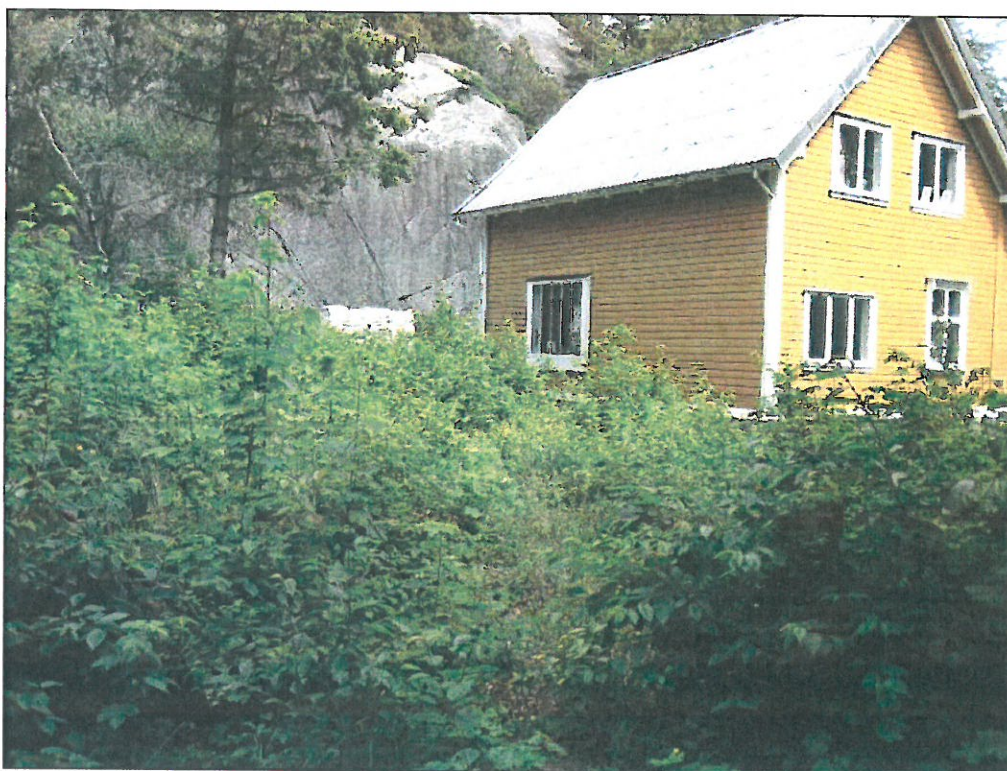
Figur 3.1 Vokterbolig og hage før tiltak
