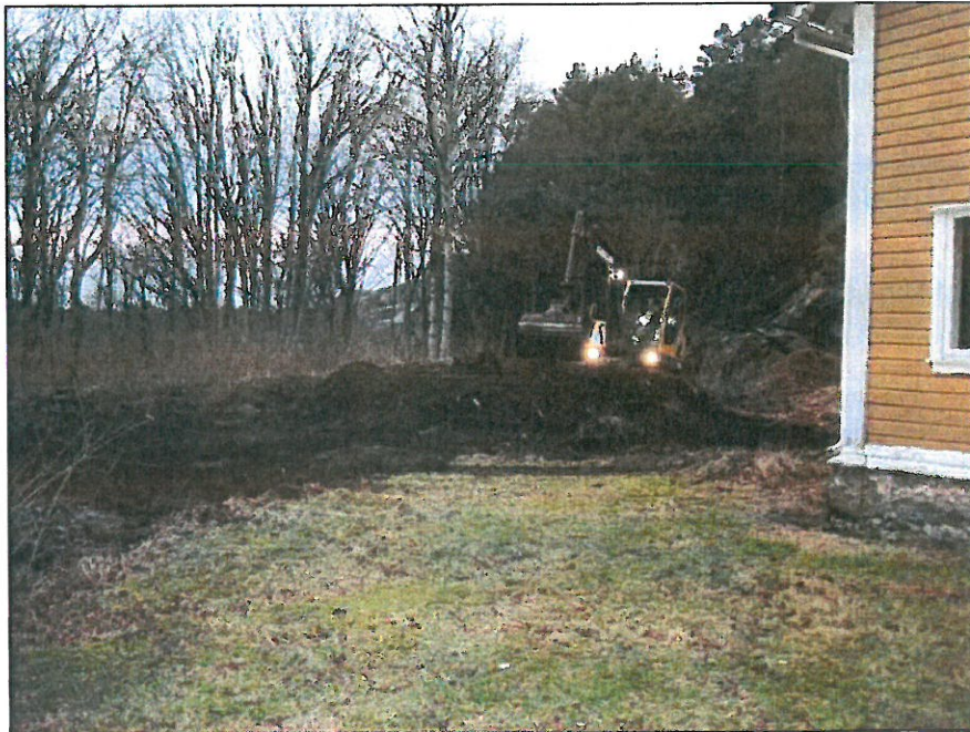
Figur 3.2 Oppstart av restaurerende tiltak.
