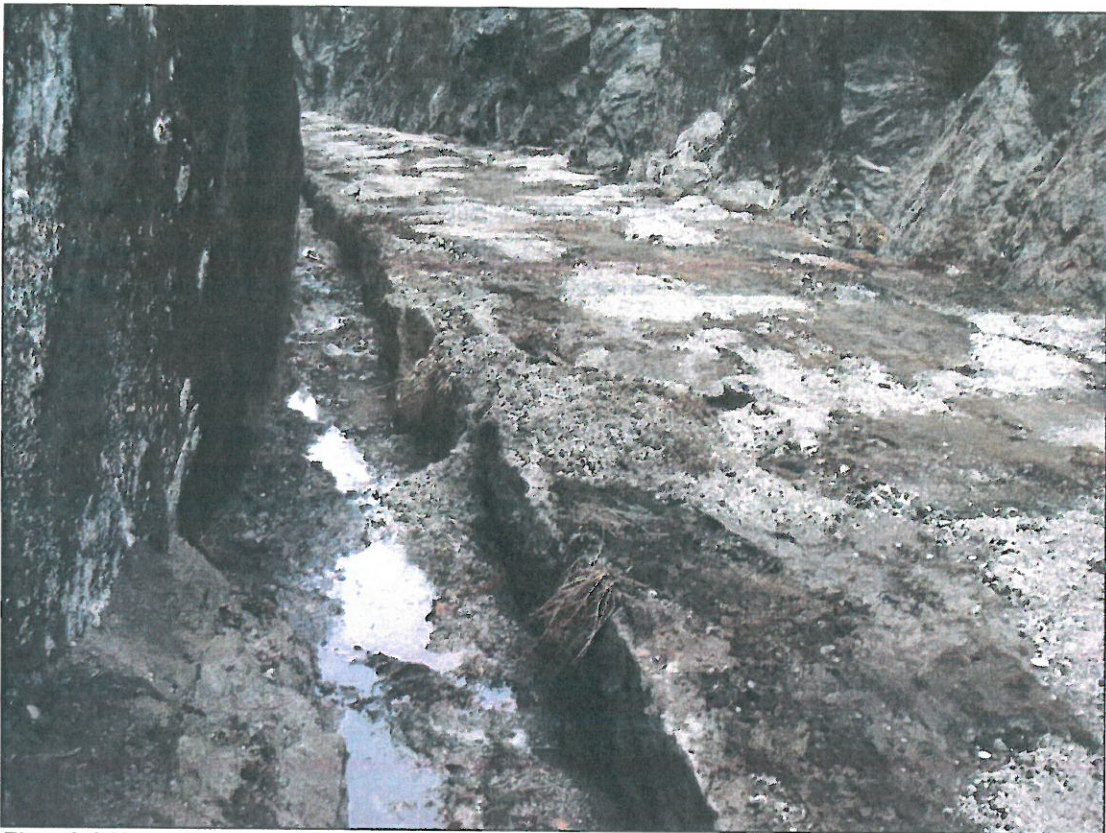
Figur 3.6 Utbedring av grøfter og veidekke.
