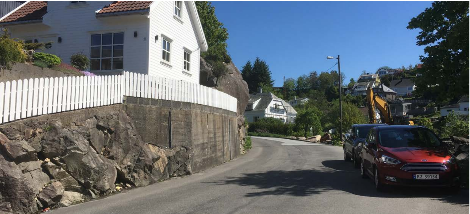
Skomakersvingen/Sandersvingen, her blir veibredden begrenset til 6,1 meter, med parkeringslomme og fortau på innsiden.
