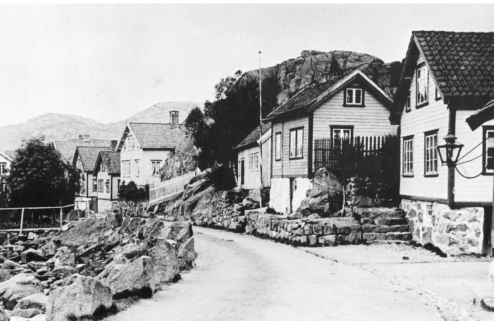
Nyeveien ved Langaardsgate, P.A Flak 1869-1897. Foto: ©Dalane folkemuseum
