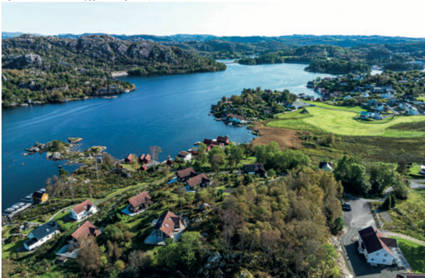
Figur 8: Eksisterende bebyggelse i - og rundt planområdet.
