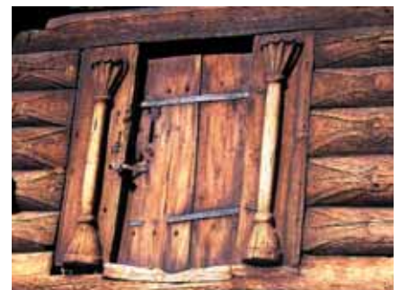
Detalj fra Guggedalsloftet, Suldal. Foto: Synnøve Hognestad.
