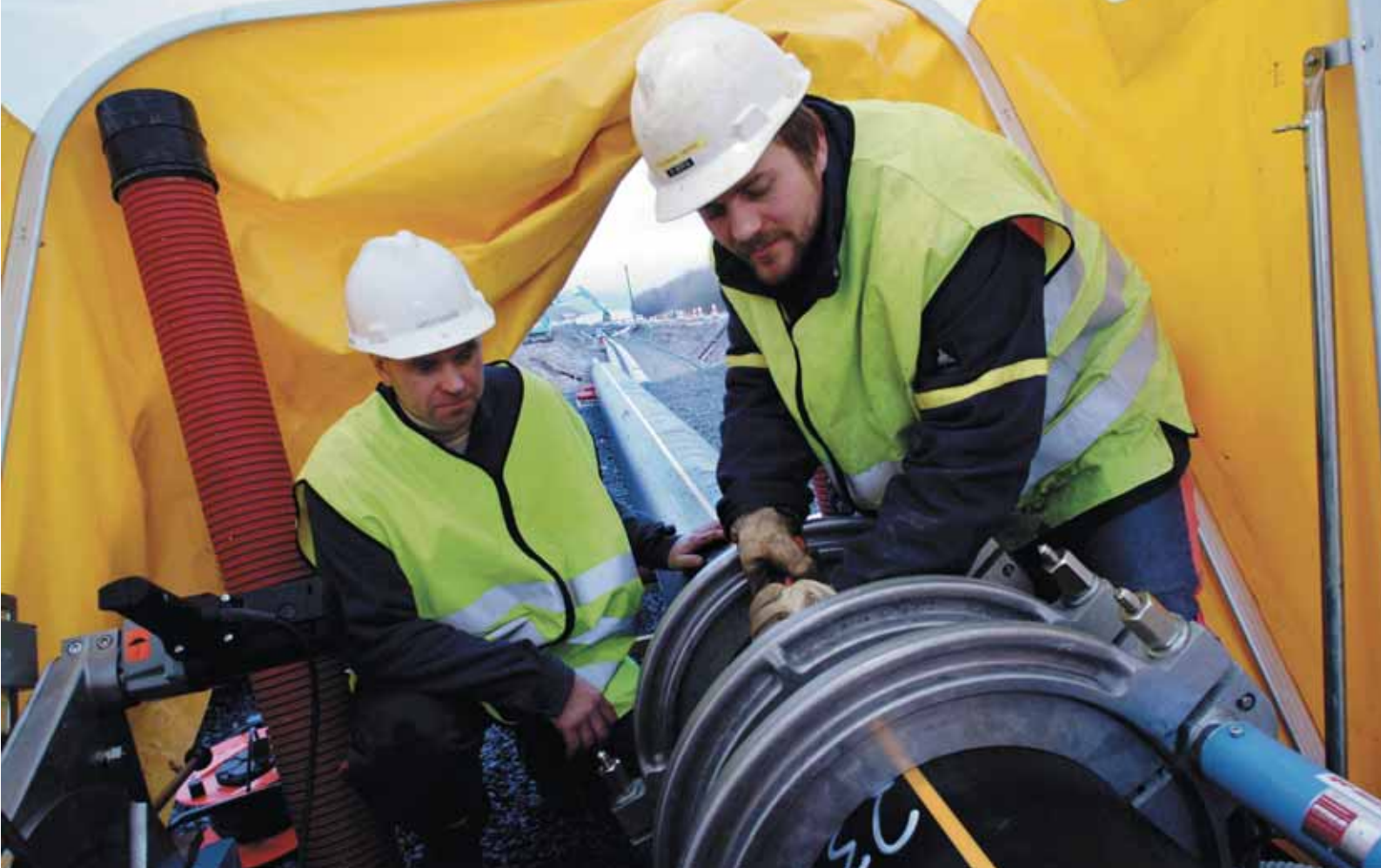
Legging av gassrør. Foto: Lyse
