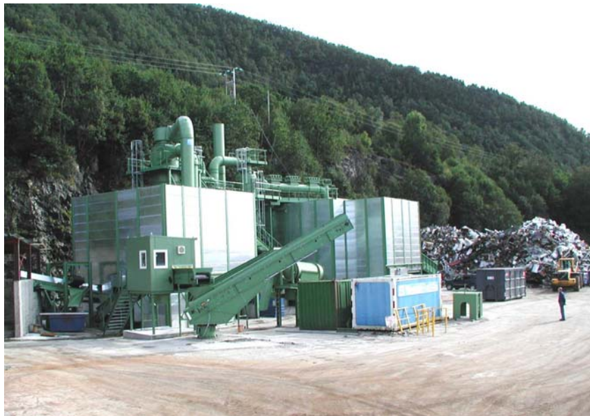
Bilde 2: Fragmenteringsanlegget i Vartdal
