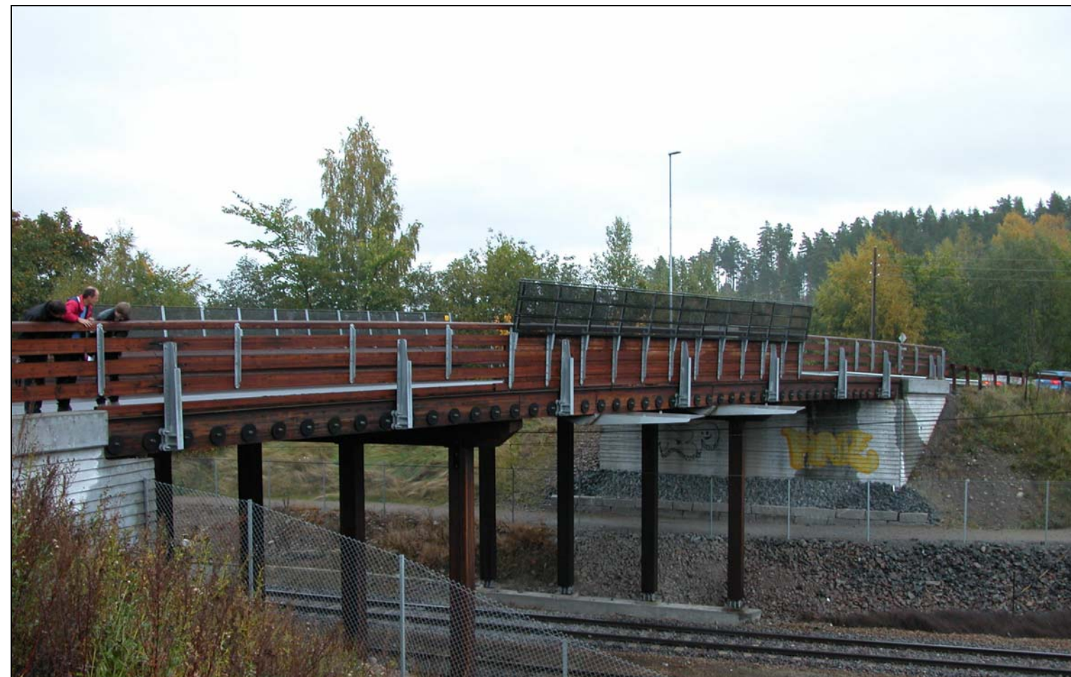
Figur 4: Eksempel på trebru over jernbane. Dette er ei køyvebru. Eksempelen er henta frå Tangen bru ved Stange stasjon i Hedmark.
