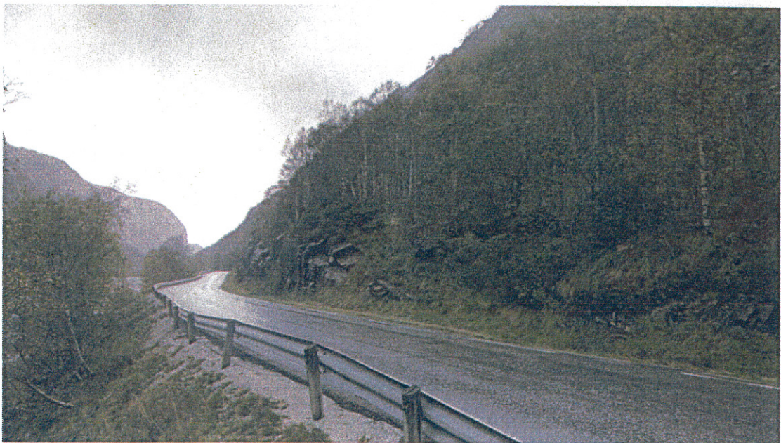
Foto 5 Ny veilinje ligger inne i skråningen til høyre på bildet
