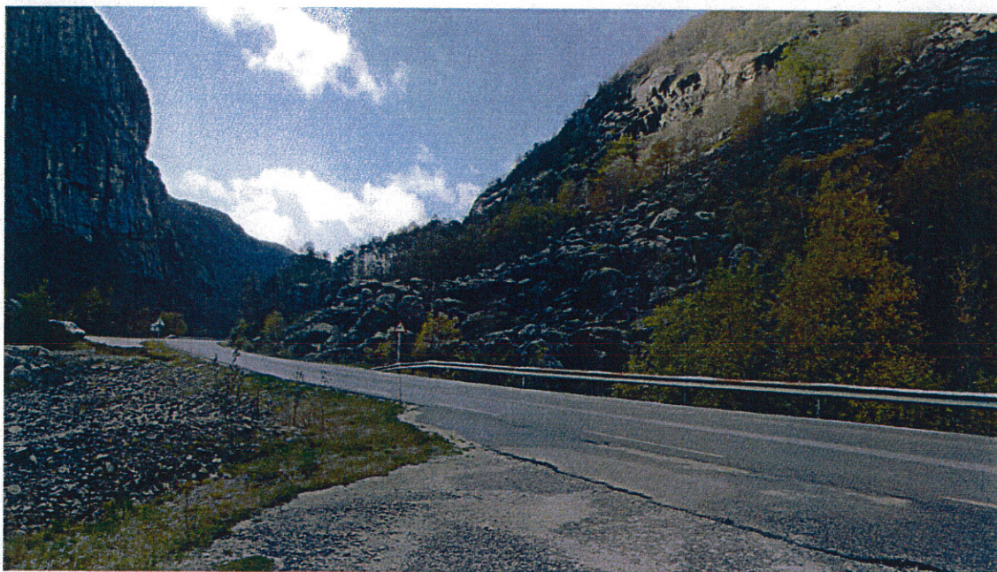
Foto 9 Bildet viser området hvor det må foretas graving i urskråningen for etablering av ny veillinje
