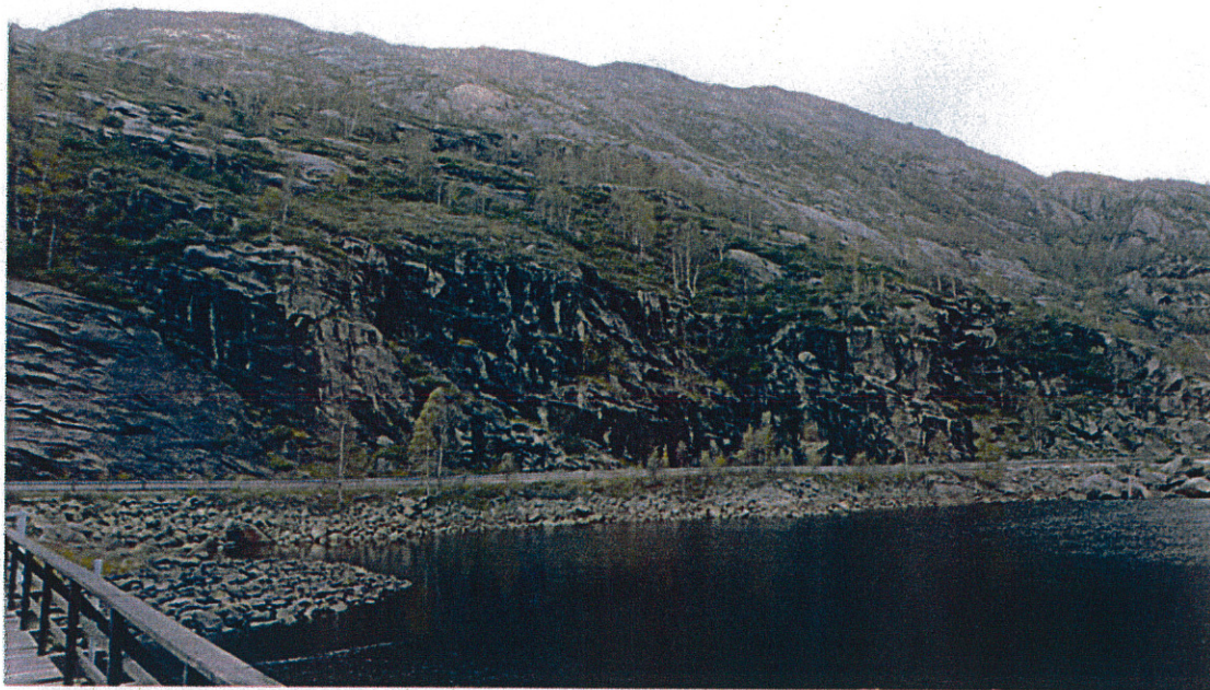
Foto 7 Ca. profil 500-600. Ny veillinje i området midt på bildet er flyttet ut i vannet. Videre mot høyre på bildet ligger ny veillinje inni bergmassivet som medfører utspregning av høye fjellskjæringer.
