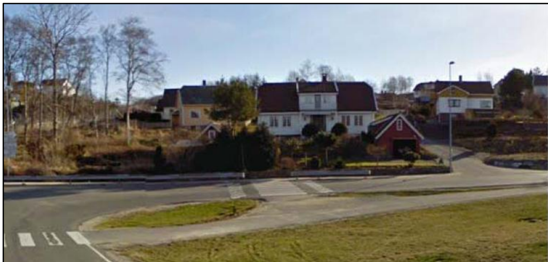
Figur 5. Opphøyd gangfelt over Kvidafjellveien. En forbedring av gatebelysning anbefales, slik at gangfeltet belyses bedre.
