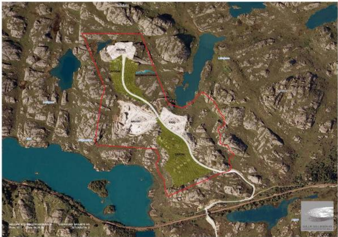
Figur 33. Eksisterende deponi revegetert, riggområde, vei og bruddområdet – Tofjellet
