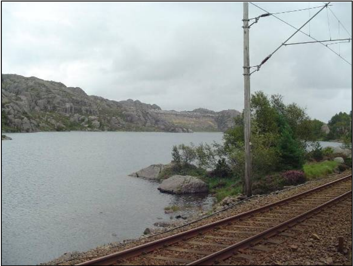
Figur 29. Dagens massedeponi sett fra jernbanelinjen ved Sørå Krogavatnet. Deponiet er under opparbeidelse med suksessiv påfylling av løsmasser etter hvert som det fylles opp. Over tid vil naturlig revegetering gi en god tilpasning til omgivelsene og området vil fremstå som naturmark..
