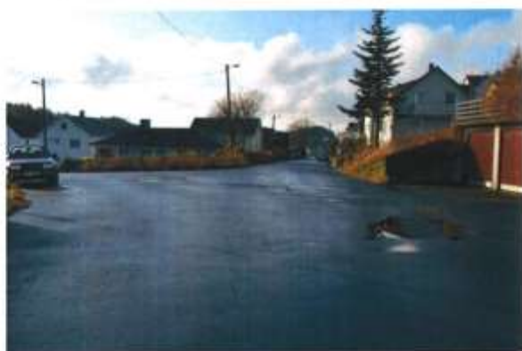
Bilde 1 Krysset der Eigersundsveien og Høgevollsveien møtes er et ukanalisert X-kryss. Utformingen skyldes avstikkere fra begge veiene. Den ene blindvei med atkomst til boliger; den andre en gjennomfartsåre til parallell vei, Gamleveien. Krysset fremstår som relativt åpent og oversiktlig, men med utydelig kjøremønster. Utformingen nærer uønsket høy hastighet i området.
