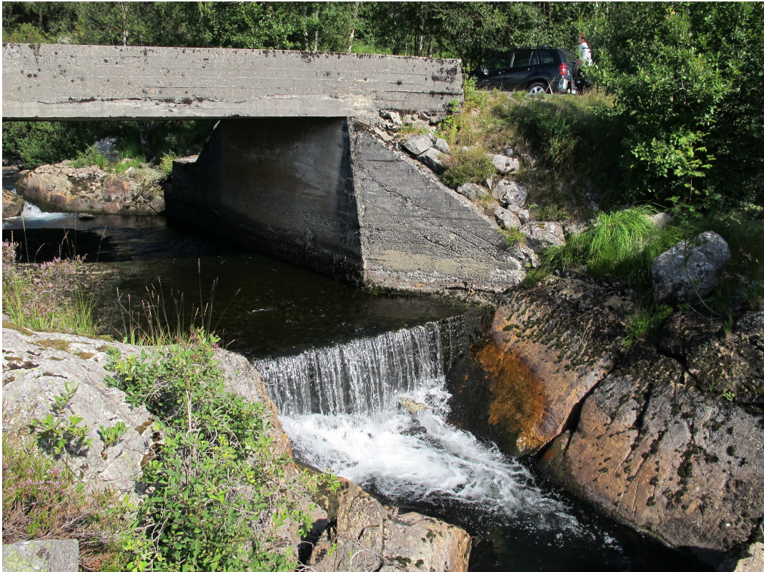
Figur 6.1 Vandringshinder i form av terskel nedstrøms Stokkurhølen i Grødeimelva.
