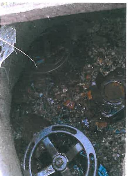
I forbindelse med vedlikehold/befaring av brannkummer og eget vedlikehold/inspeksjon av avløpskummer, ble det oppdaget mange kummer som var i dårlig forfatning; ventiler som ikke stenger, knuste rør, forskjøvne kumringer og lignende.
