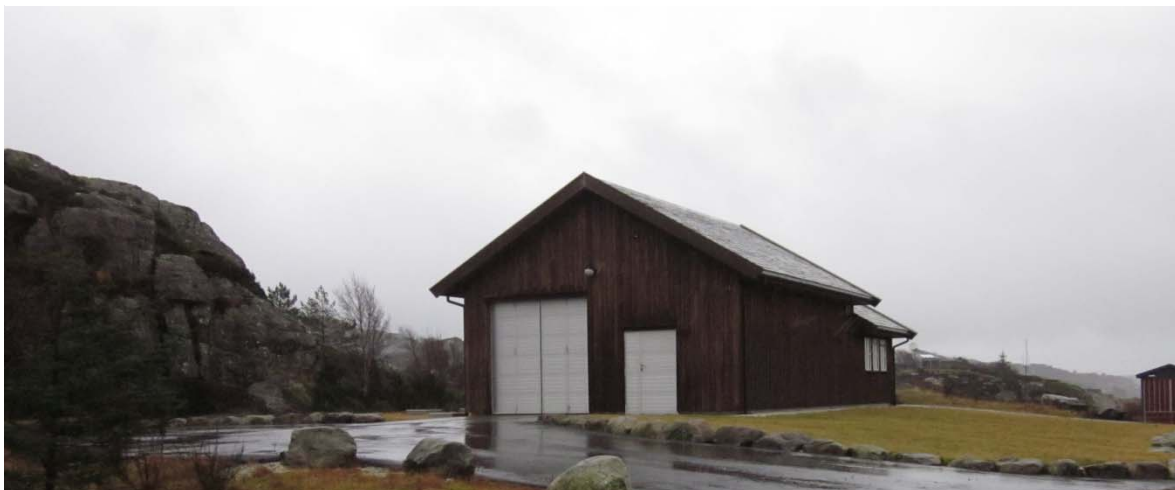
Figur 10: Trosaviga renseanlegg. Foto viser bygningsvolumet på Trosaviga RA. Det planlegges tilsvarende bebyggelse på Birkeland. Foto: Svanur Arnason, Eigersund kommune.
