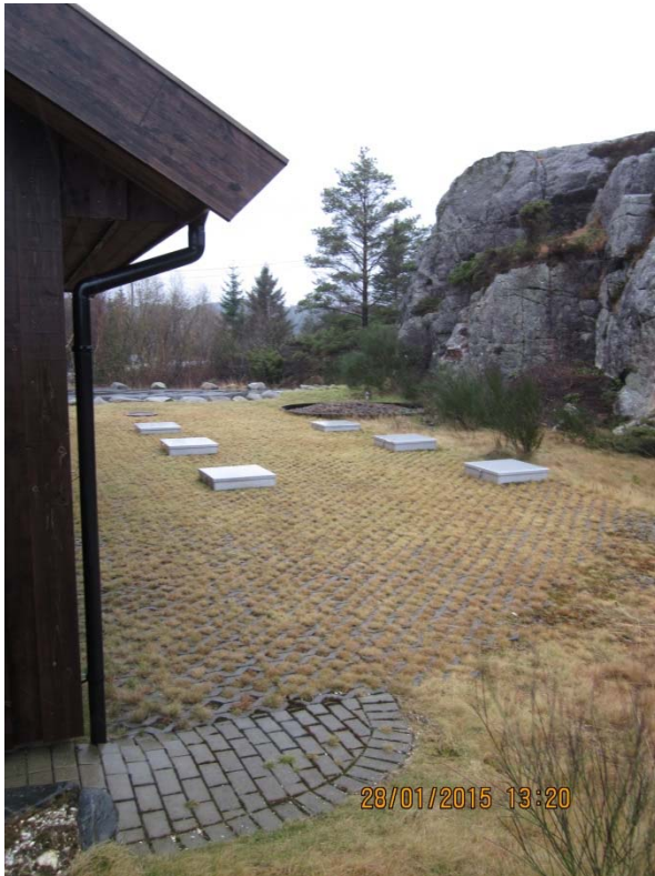
Figur 10: Illustrasjonsfoto av Trosaviga renseanlegg, Hellvik. Foto viser nedgravde tanker og barkfilteranlegg. Rundt tankene er det lagt armeringsstein og sådd til. Dette gir en god landskapstilpasning. Man ser for seg tilsvarende løsning av uteanlegget på Birkeland. Foto: Svanur Arnason, Eigersund kommune
