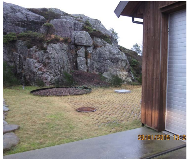
Figur 10: Illustrasjonsfoto av Trosaviga renseanlegg, Hellvik. Foto viser nedgravde tanker og barkfilteranlegg. Rundt tankene er det lagt armeringsstein og sådd til. Dette gir en god landskapstilpasning. Man ser for seg tilsvarende løsning av uteanlegget på Birkeland. Foto: Svanur Arnason, Eigersund kommune
