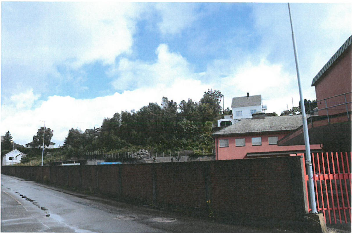
Fra Elganeveien mot Elgjebakken. Eksisterende skråning og vegetasjon. Denne opprettholdes i planforslaget som en vegetasjonsskjerm mellom boligfeltet på Elgjebakken og næringseiendommen i Elganeveien 1.
