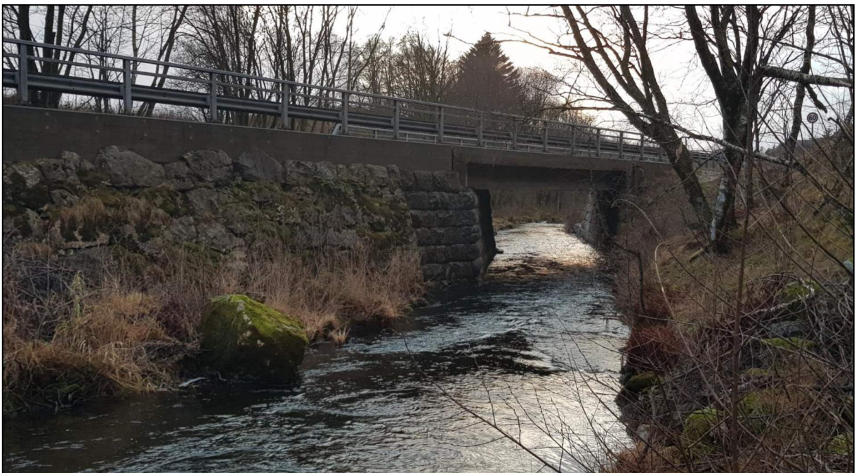
Figur 6: Bru ved Jærveien.
