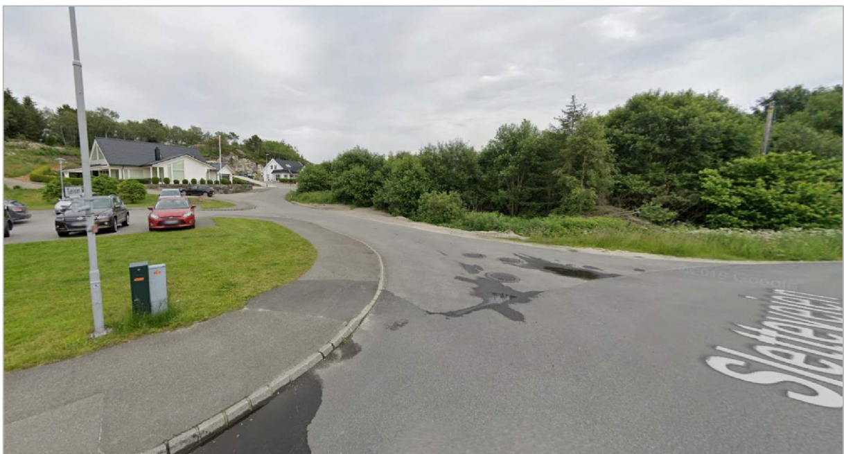
Figur 10 Bilde av eksisterende situasjon, viser krysset inn til Tueveien, sett fra Sletteveien. Bildet er hentet fra Google maps.
