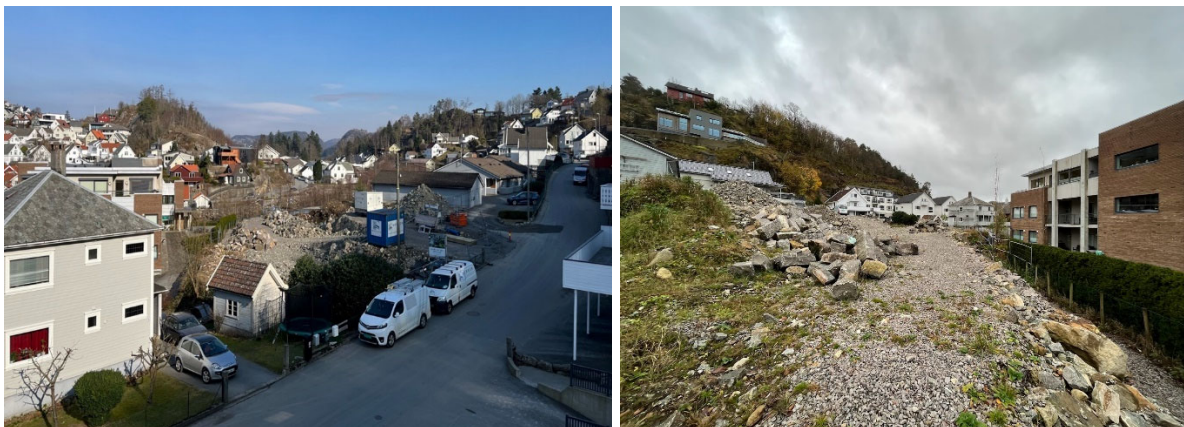
Figur 2 Foto av dagens situasjon. Tidligere bebyggelse på tomte er revet og det er utført noe grave- og terrengarbeider. Bilde til venstre er tatt fra Sandbakkveien 17 og bilde til høyre er tatt nord på tomte mot Sandbakkveien.
