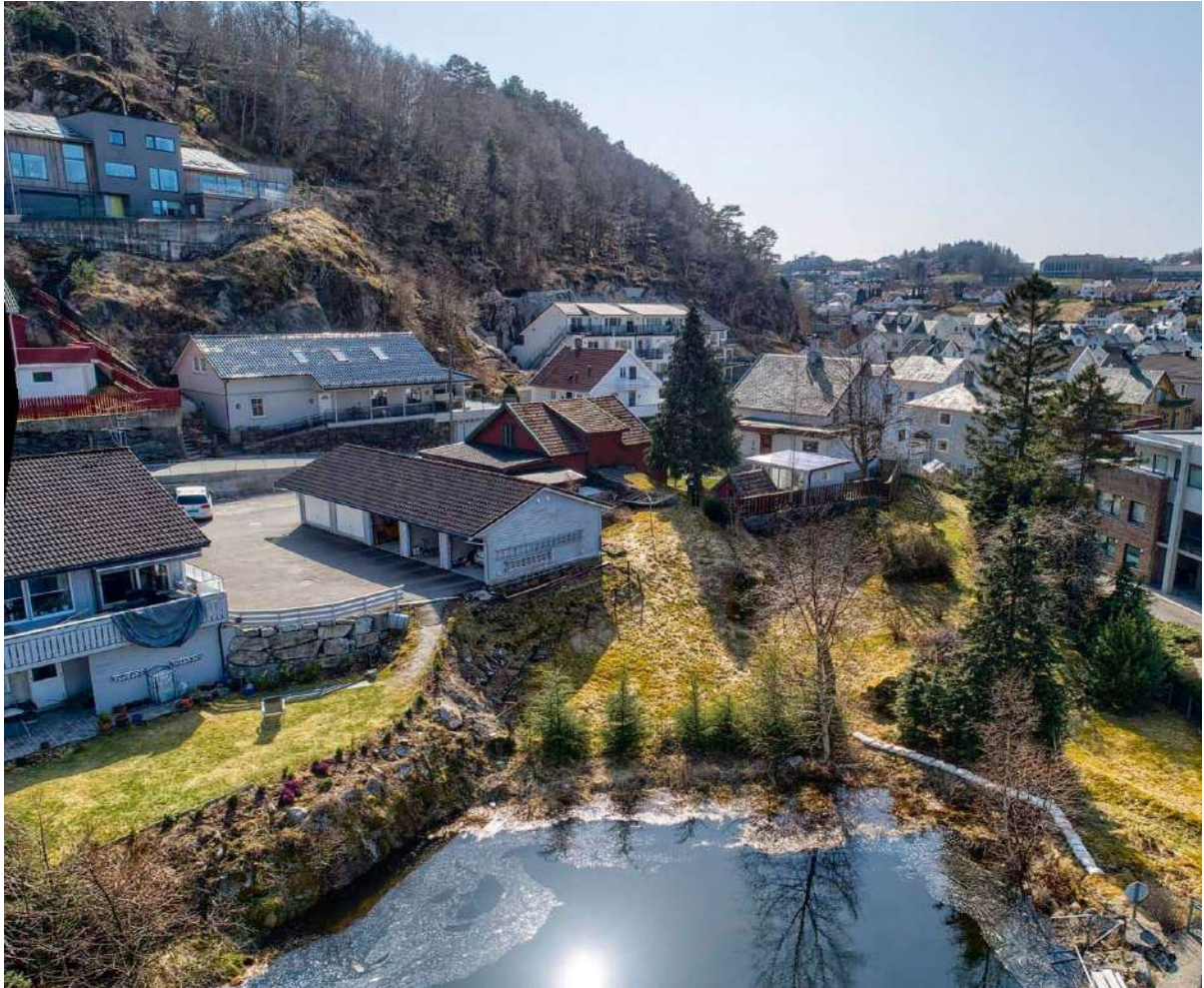
Figur 10: Planområdet sett fra nord. Idyllisk vannspeil ved demning til kraftstasjonen nedenfor tomten i nord. Foto: Norrøn Bolig AS
