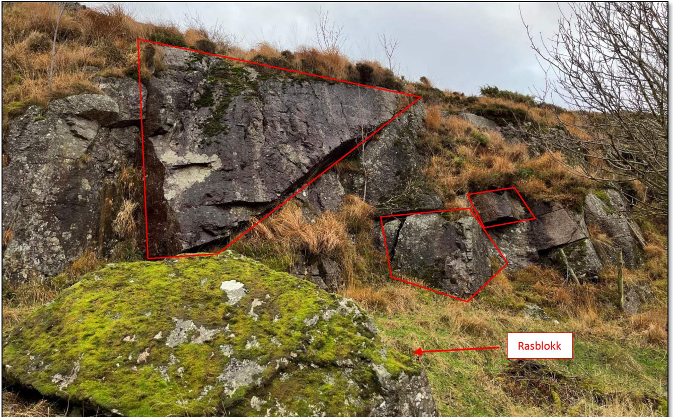
Foto 3: Sørvestlige del av nedre bergskrent. Blokker som er vurdert til å på sikt potensielt kunne løsne og rase ut er markert med rødt. En rasblokk er markert med rød pil.
