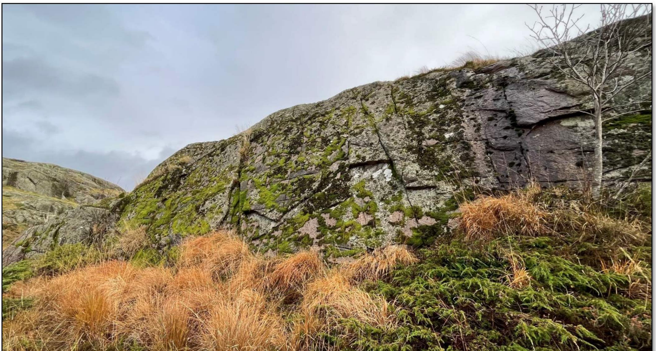
Foto 4: Øvre bergskrent. Det er flere delvis løse flak/blokker i bergskrenten, men på grunn av bred hylle i underkant vurderes det ikke behov for sikringstiltak ved dette området.
