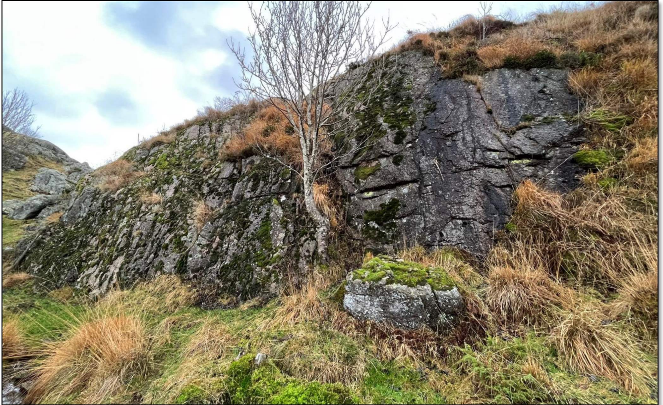
Foto 2: Nordøstlige del av nedre bergskrent. Her er det ok bergmassekvalitet, og vurdert ikke behov for sikringstiltak ved dette området.
