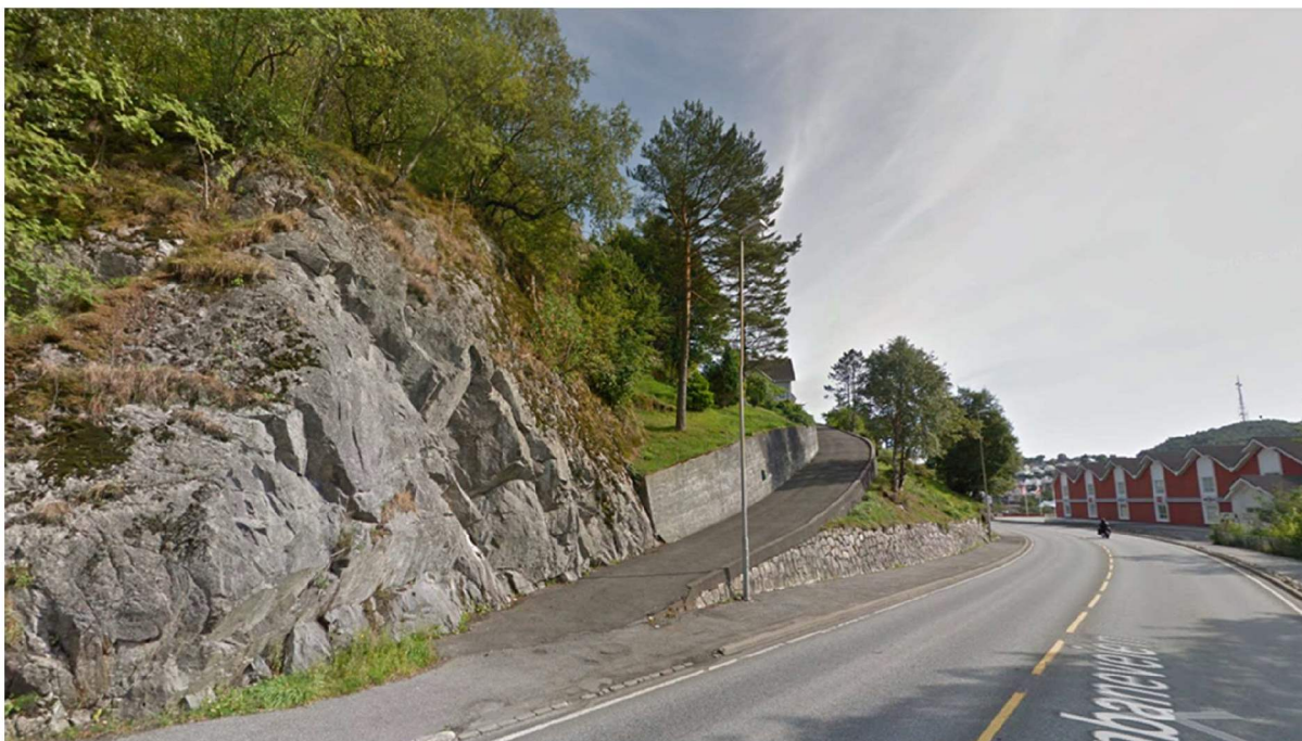
Figur 4-5: Planområdet sett fra Jernbaneveien, med vei opp til Jernbaneveien 19. Kilde: Google Maps.
