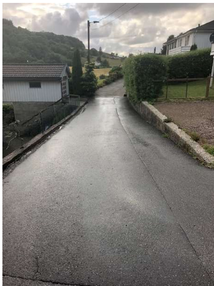
Figur 6-2 Humlestadgaten mot nord ses med en smal vegbredde.
