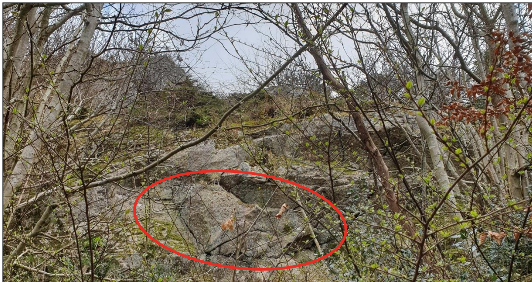
Figur 9: Utløsningsområde 1. Sprekkeavløst parti hvor en enkeltblokk ligger langs et sprekkeplan med fall ut i skjæringen. Løsnesannsynligheten er vurdert til > 1/5000 .
