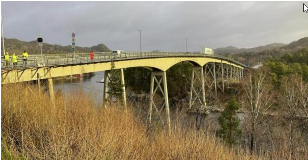
Figur 3 Bilde av dagens bru
