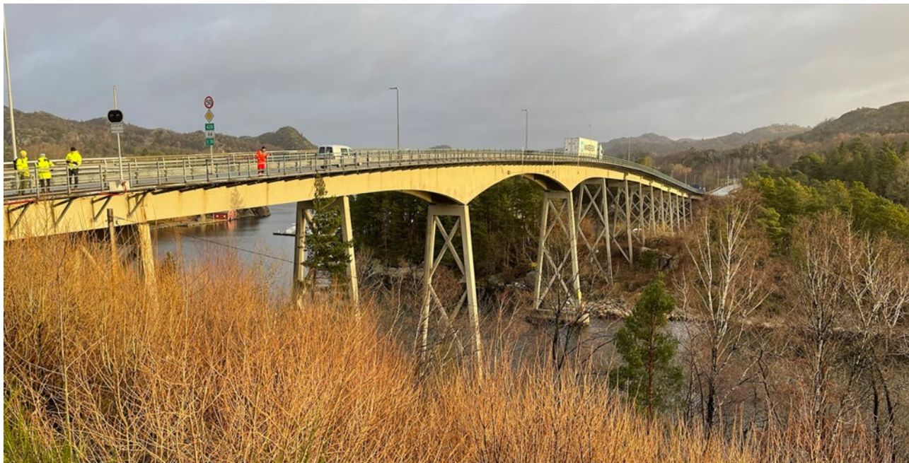
Figur 4-2 - Dagens bru til Eigerøy (bilde: Multiconsult)
