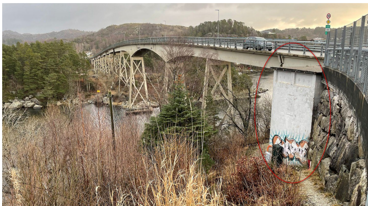
Figur 4-13 Trafoanlegg ved nordsiden av dagens bru. (bilde: Multiconsult)
