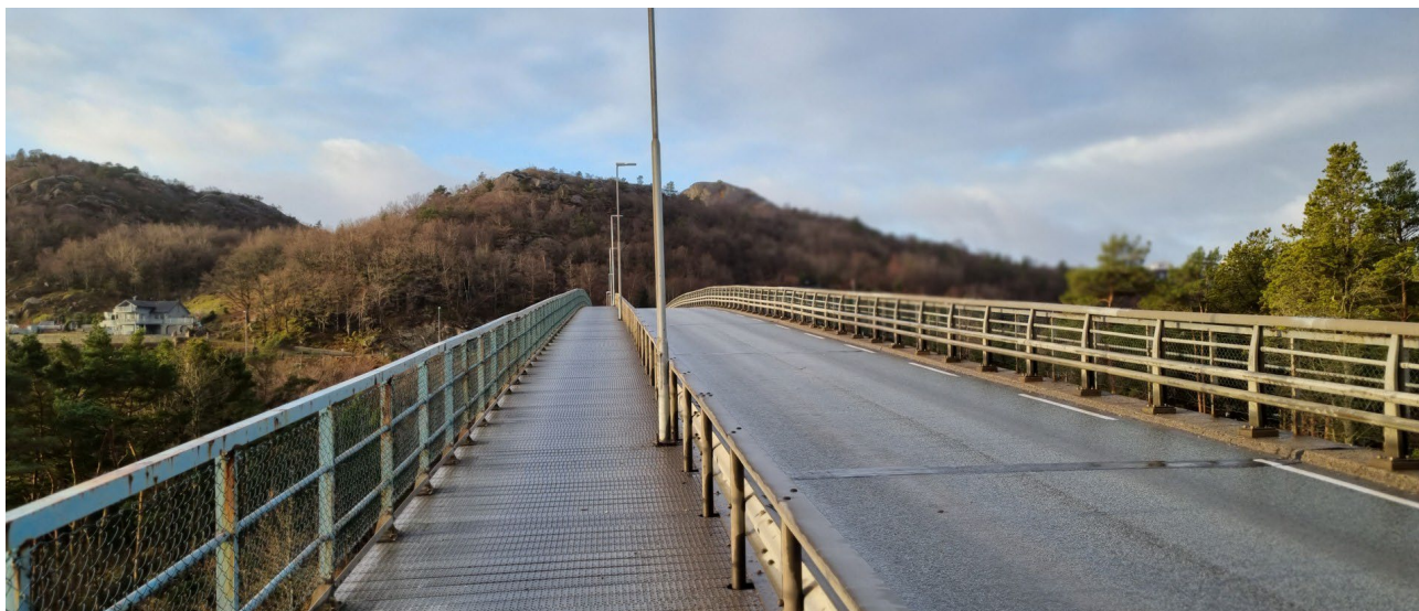
Figur 4-9 - Dagens bru til Eigerøy (bilde: Multiconsult)
